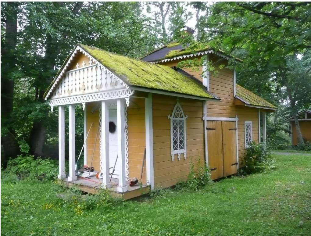
Sundholman kartanon uusgoottilainen käymälärakennus.
