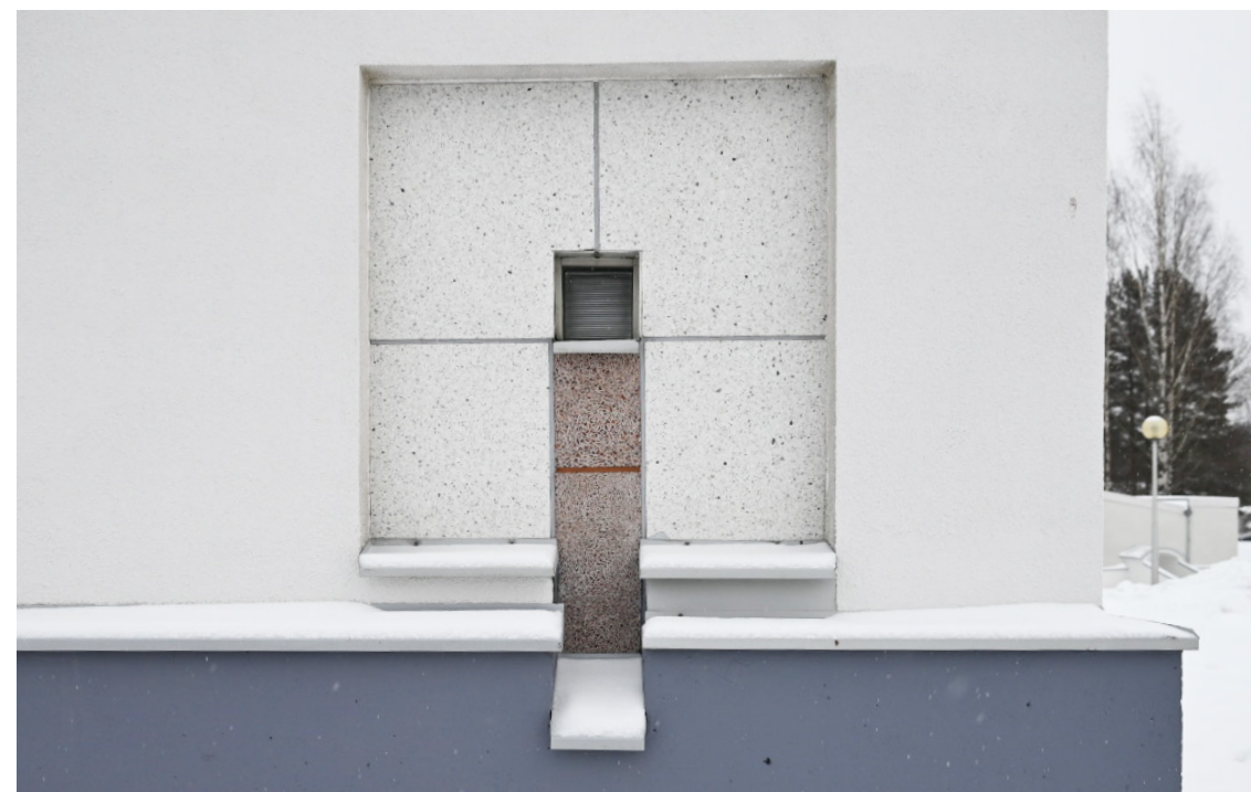
Osa julkisivujen kivilaatoista on vaurioituneita. Julkisivujen koristeaiheet ovat osin hyvässä kunnossa.
