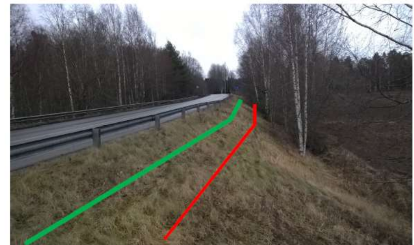
Kuva 10: tie 322, Reunakaideoisuus. Sisäluiskan kaltevuus 1:15-1:2 ja leveys 4-5 m. 20 kV kaapelin sijoitus sisäluiskaan enintään 1 m etäisyydelle olevan telekaapelin ulkopuolelle.
