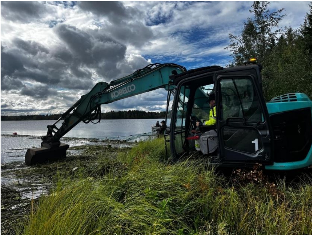
Kuva 12. Pehmeälle rannalle jouduttiin hakemaan pienempi kaivuri kasvillisuuden keräykseen
