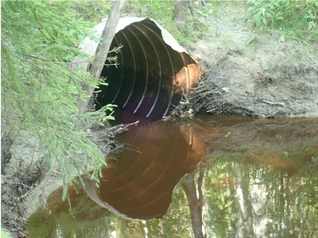
Kuva 5. Metsäautotien alittava esteellinen tierumpu nro 2.
