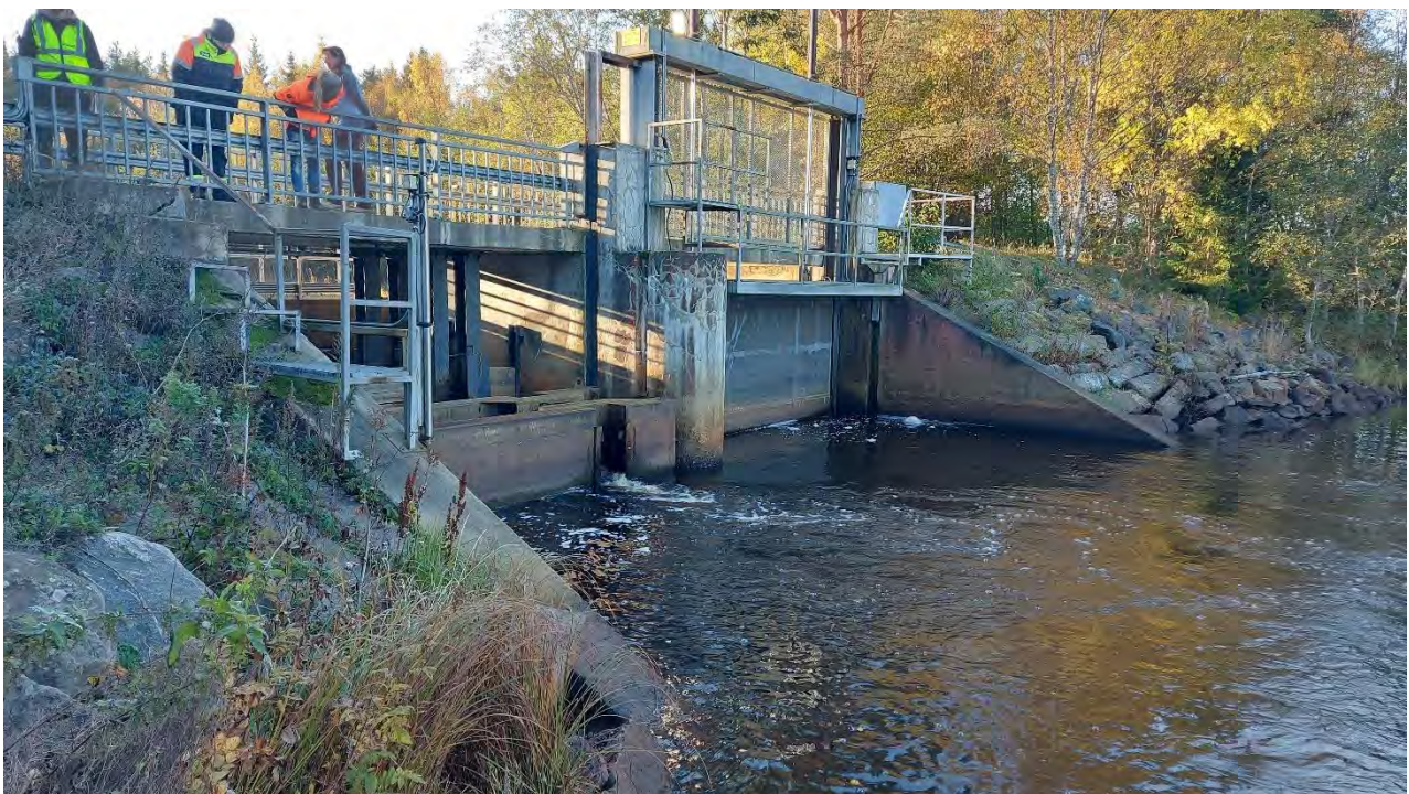
Kuva 2-1: Piehingin pato, näkymä alavirran puolelta. Vasemmanpuoleisessa aukossa näkyy tekninen kalatie, oikeanpuoleisessa aukossa tulvaluukku.
