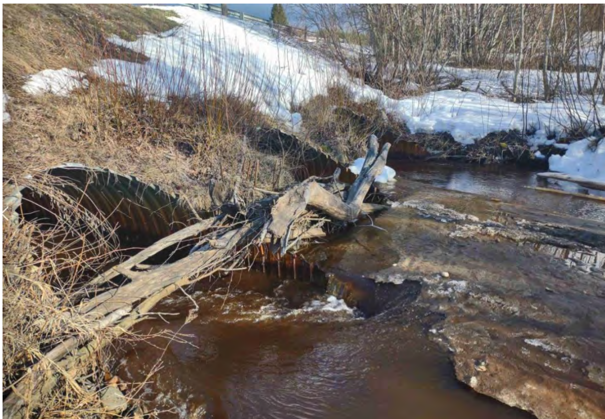
Kuva 4-2. Jokelankyläntiellä sijaitse kolmoisrumpu kuvattuna 23.4.2022 (Kuva Markus Niemelä).
