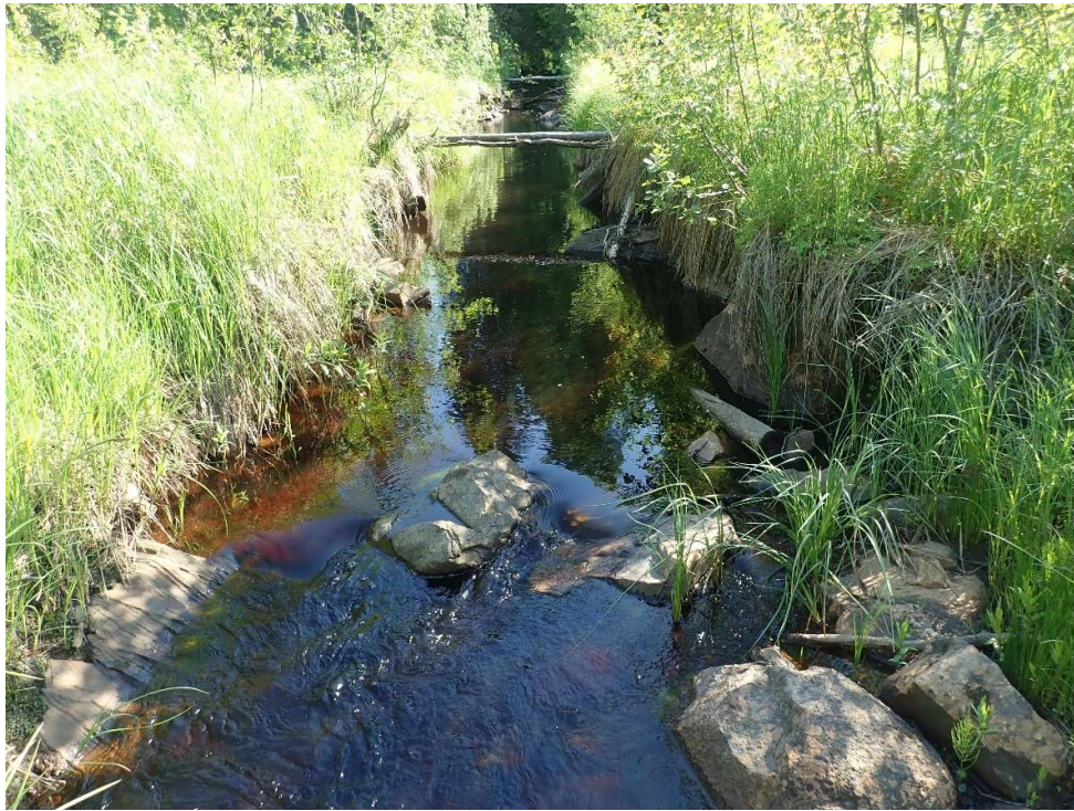
Kuva 19. Pajukanavan kaivettu uoma
