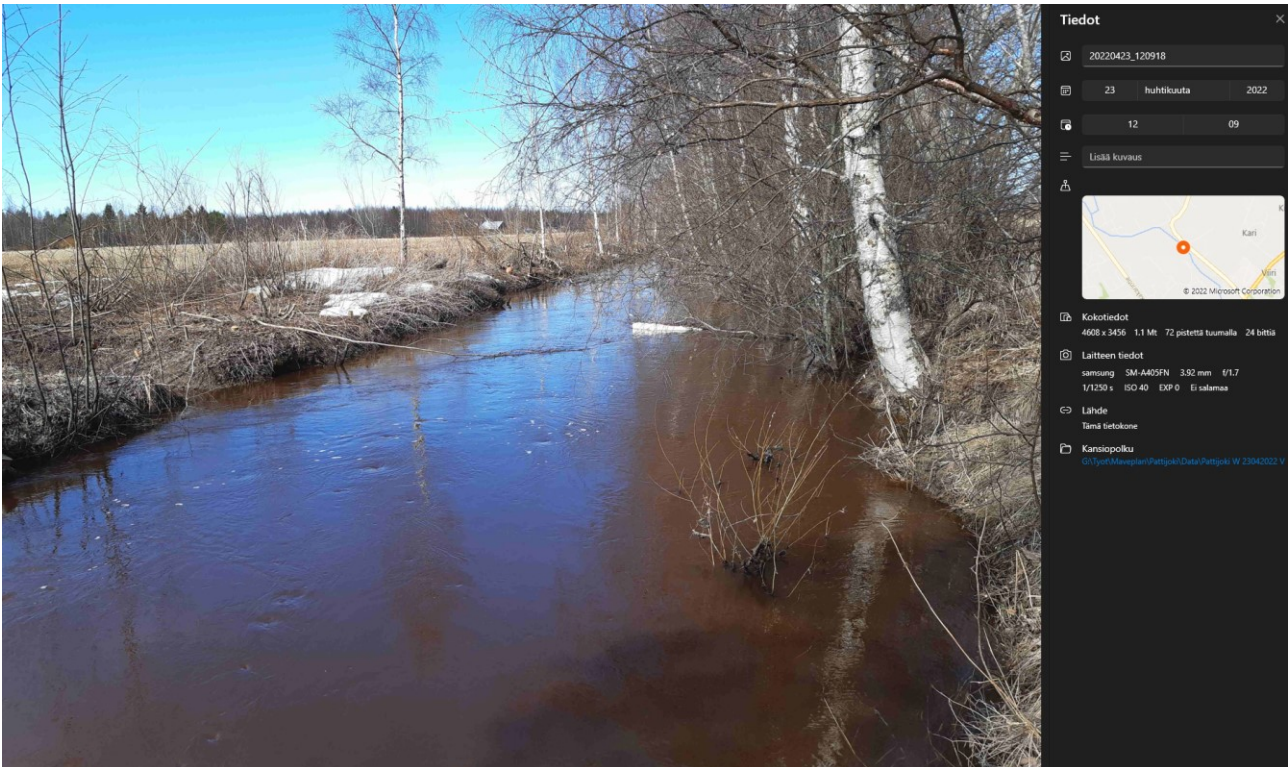
Kuva 29. Osin raivattua, oikea puoli uomasta tarvitsisi vielä raivausta. Kuva Markus Niemelä 23.4.2022.
