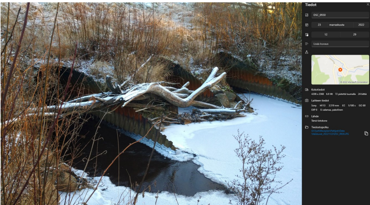
Kuva 16. Syksyllä 23.11.2022 sama kohde kuvattuna, pääosin samat rungot kuin keväällä näyttävät edelleen tukkivan rumpuja. Kuva Pekka Leiviskä.
