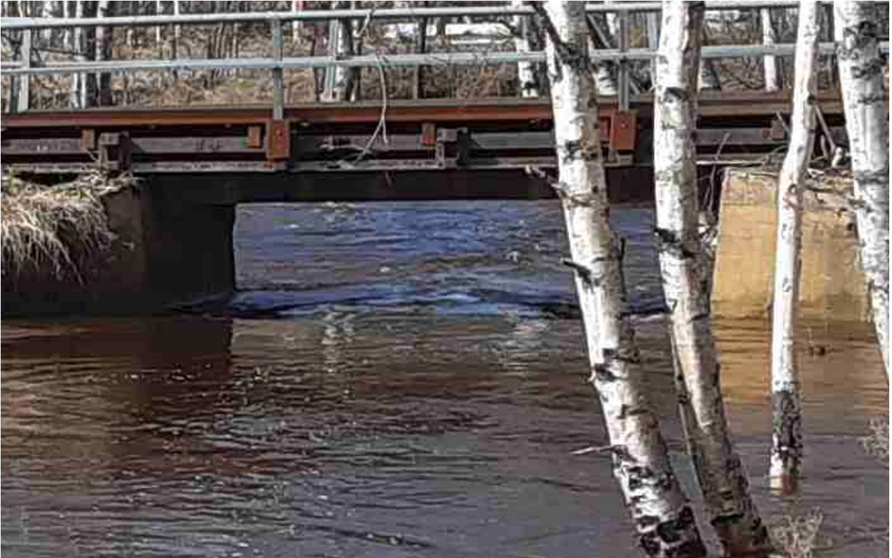
Kuva 9. Silta 21 lähikuvassa, virtaama noin 5,0 \text{ m}^3/\text{s} . Kuva Markus Niemelä 23.4.2022.
