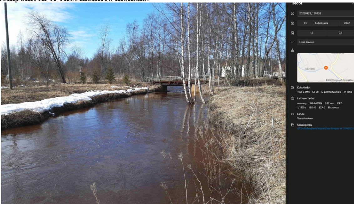
Kuva 8. Silta 21 ylävirran puolelta kuvattuna 23.4.2022. Kuva Markus Niemelä.
