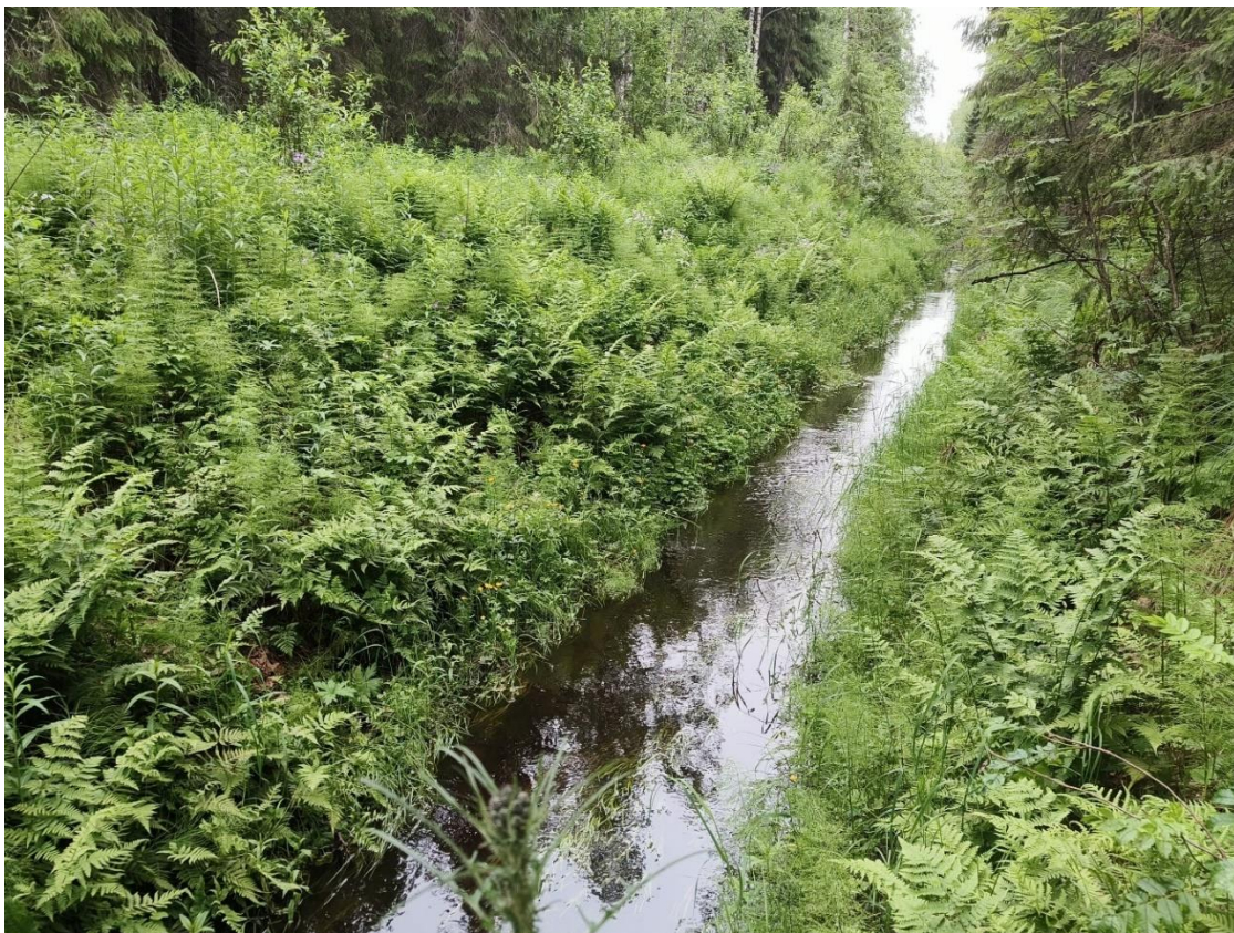
Kuva 23. Uoman yläosan suoristettu osuus (nro 53). Uoma kulkee korkeiden perkausvallien välissä.
