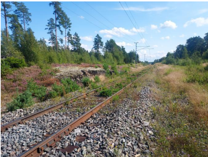
Tasoristeyksen länsipuoleinen kallioleikkaus. radan eteläpuoleinen niitty on heinikoitunut.
