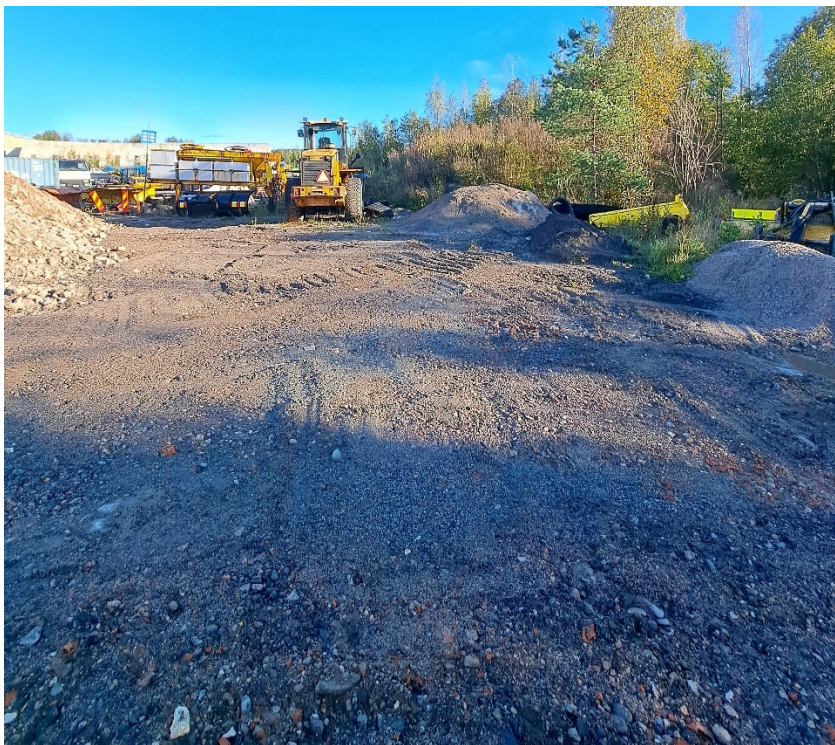
Kuva 14. Jätetäytön päällä sijaitsevilla kentällä säilytyksessä työkoneita ja koneenosia. Takavasemmalla Remeo Oy:n toiminta-alue.
