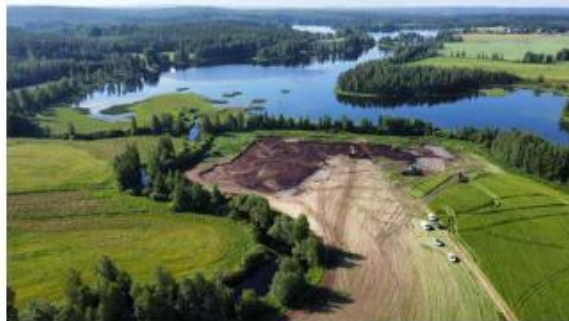
Alkuvuoden 2022 kaivutyö jatkui luonnonvoimien ja kaivinkoneiden avulla. Toivonlammen Kosteikko on valmistunut. Kuva: Tuomo Laitinen
