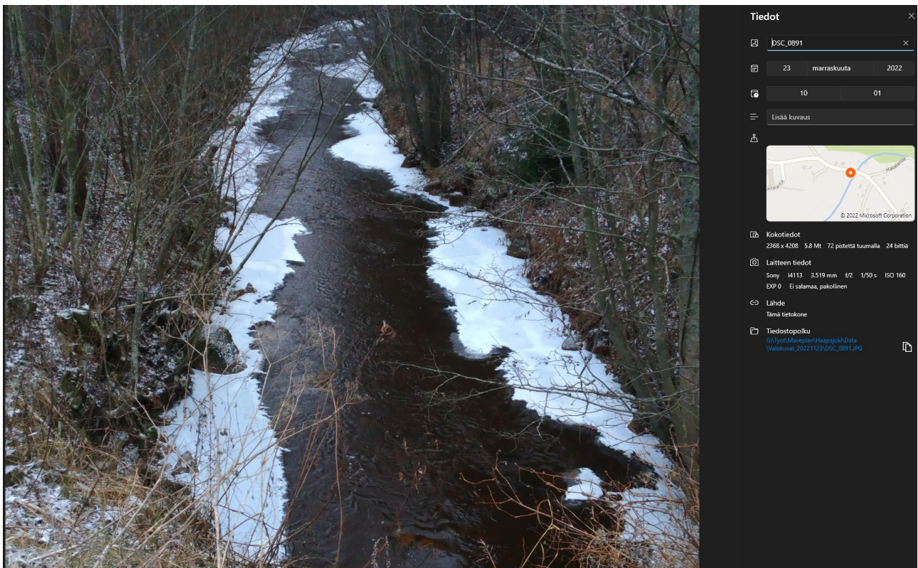
Kuva 13. Haantien ylitse menevältä sillalta alavirtaan uoma on selkeäkö mutta luiskissa paljon kasvillisuutta. Kuva Pekka Leiviskä 23.11.2022.
