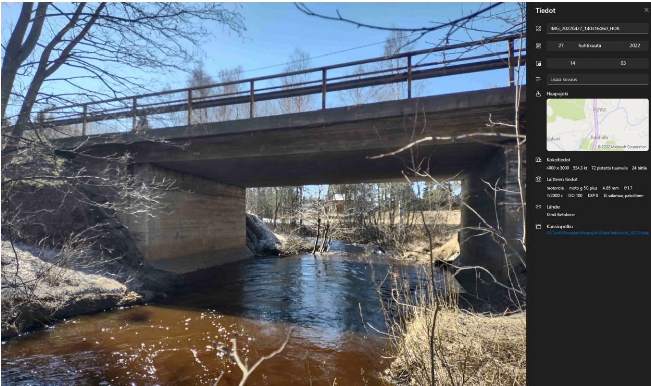
Kuva 24. 8-tien selkeä silta-aukko kevättulvalla 27.4.2022. Kuva Markus Niemelä.
