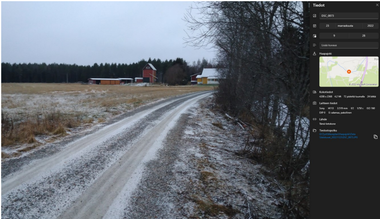
Kuva 30. Luomanmäentietä on hieman siivottu tieluiskan puolelta. Kuva Pekka Leiviskä 23.11.2022.
