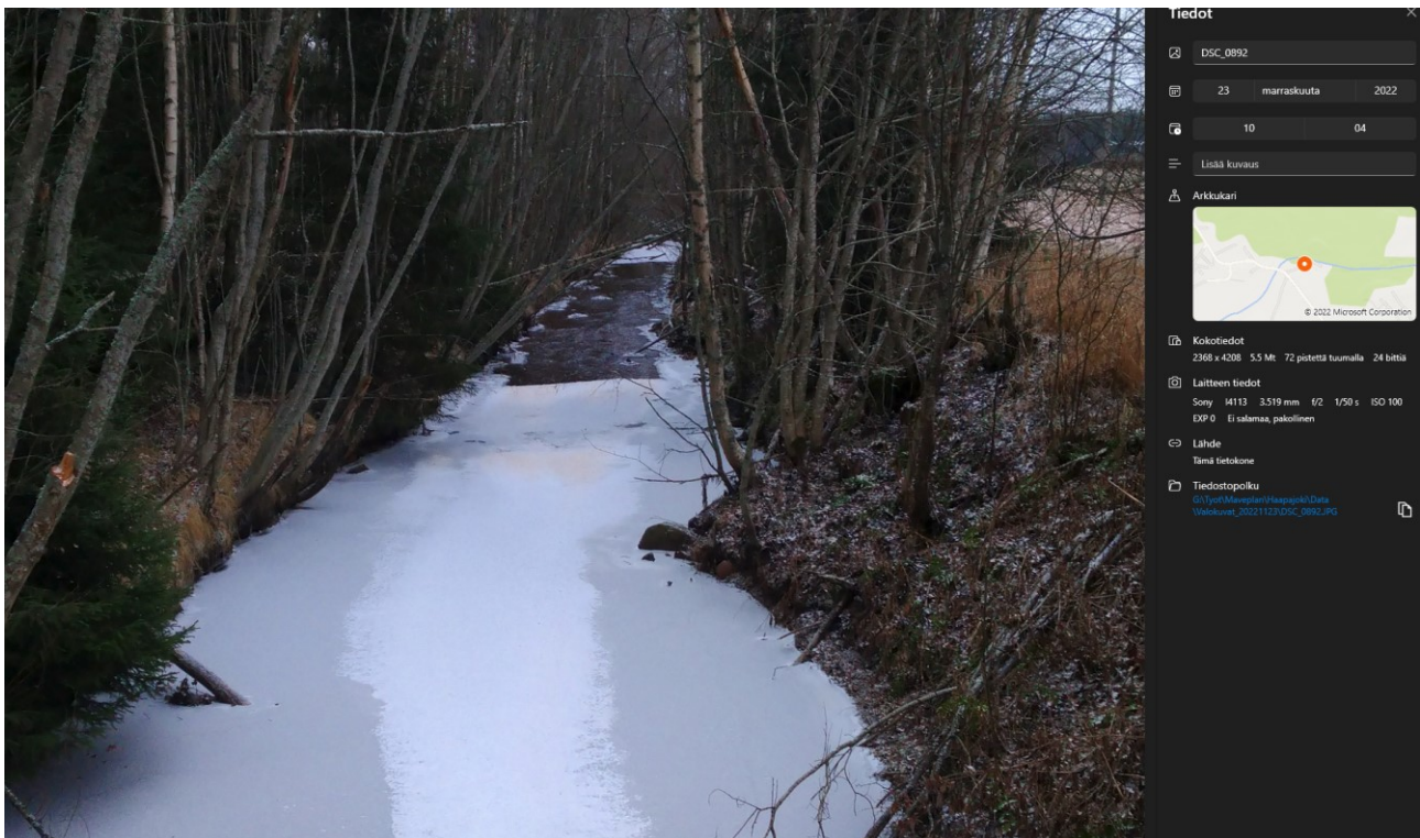
Kuva 11. Vedenkorkeuden noustessa luiskista ei saa paljon lisäkapasiteettia tulvan helpottamiseen. Kuva Pekka Leiviskä 23.11.2022.
