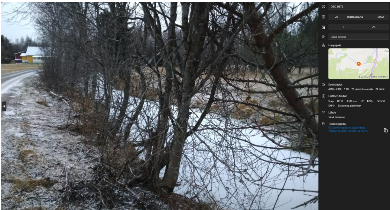
Kuva 29. Tällä alueella vesi voi nousta vasemmassa reunassa HQ1/100 virtaamalla virtaamaan Luomanmäentien ylitse. Luiskan puusto kallistelee hieman huomaan. Kuva Pekka Leiviskä 23.11.2022.
