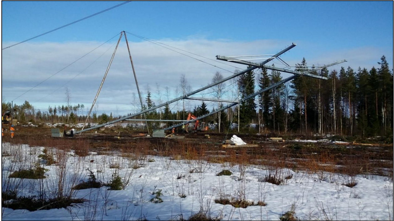
Kuva 3-7. Voimajohtopylvään pystytys.
