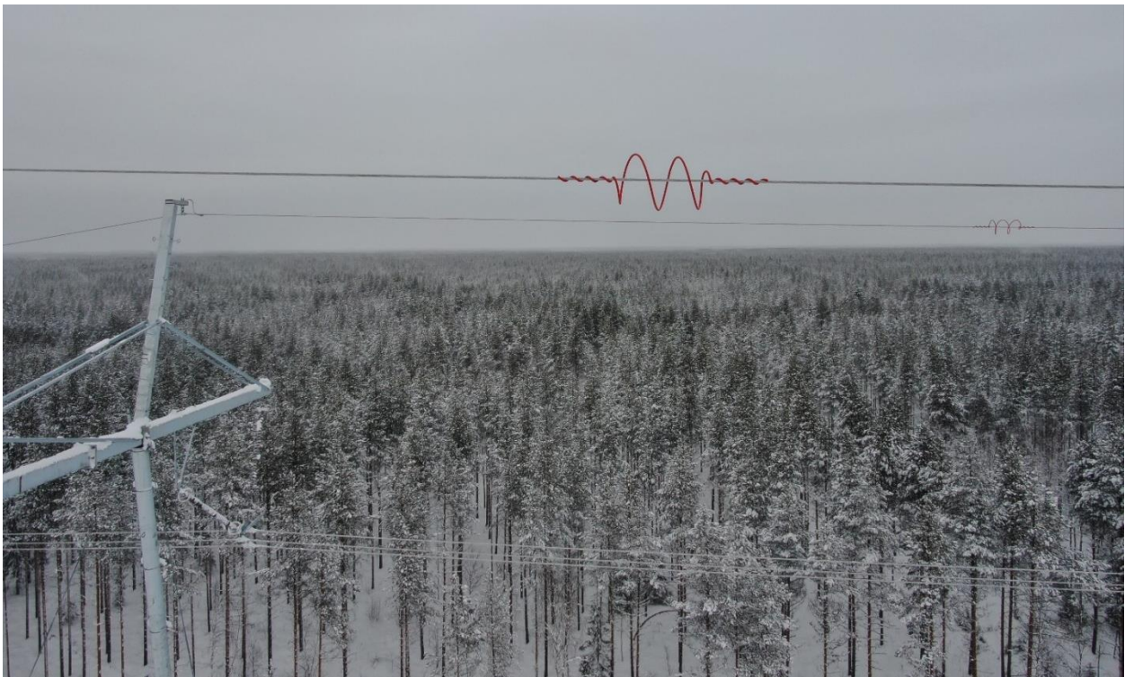
Kuva 8-4. Lintujen törmäysriskiä voidaan pienentää merkitsemällä ukkosjohtimet riskialttiissa kohdissa.
