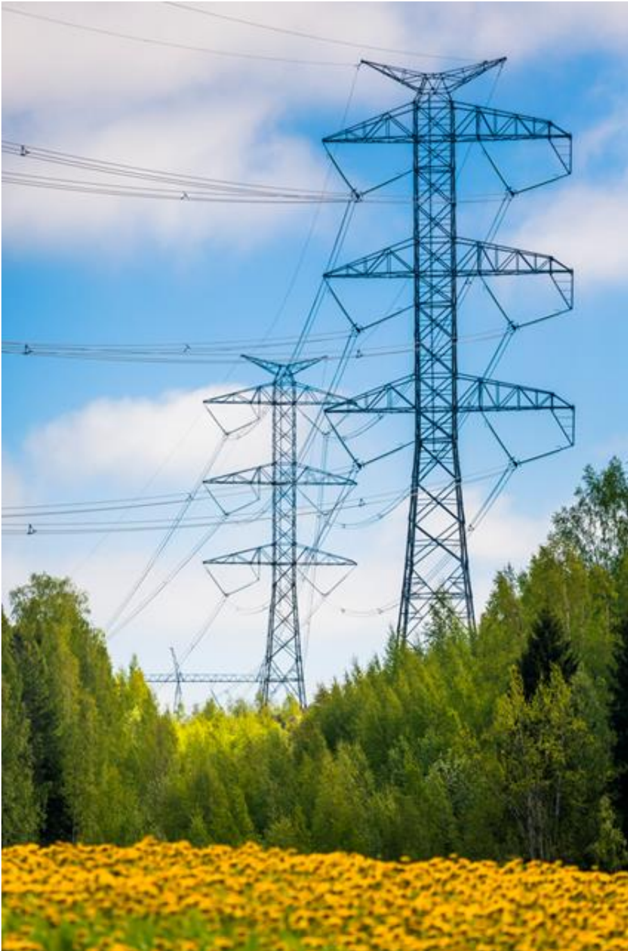
Kuva 4-46. Perusratkaisuna käytettävä pylvästyyppi on kahden 400 kilovoltin voimajohdon yksijalkainen vapaasti seisova teräsrakenteinen ristikkopylväs.
