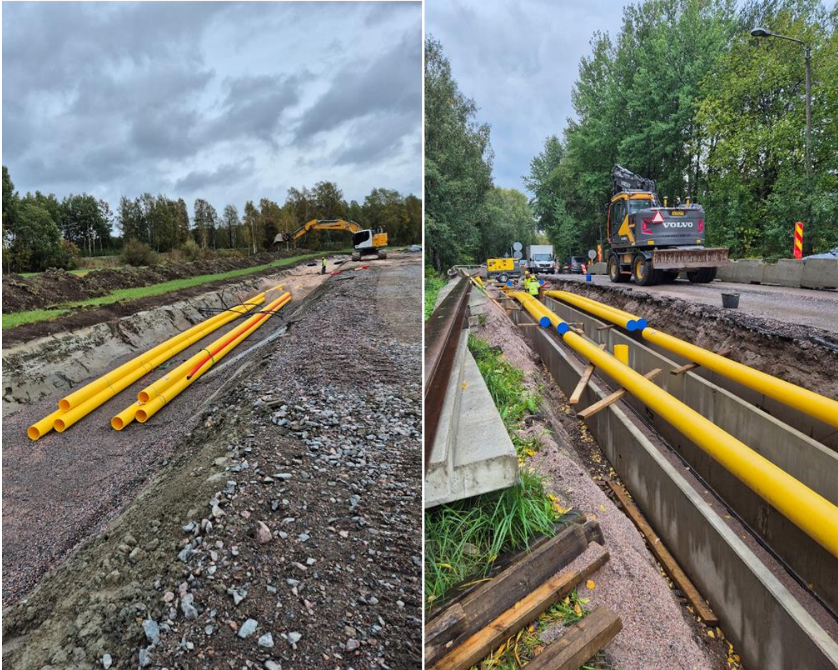
Kuva 4-3. Länsisalmi-Viikinmäki 400 kV (700 MW) maakaapelin kaivanto Viikin pelloilla ja Viikintieellä. Kuvan maakaapeliratkaisu ei täytä Fingridin 400 kV (2000 MW) rengasverkkoyhteydelle asetettuja sähkönsiirtovaatimuksia. Rakentaminen teiden yhteyteen aiheuttaa tieliikenteelle pitkäaikaista hidastumista (vasen kuva).
