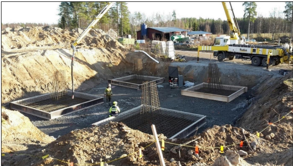
Kuva 3-5. Vapaasti seisovan pylvään perustuksen pohjatöitä.
