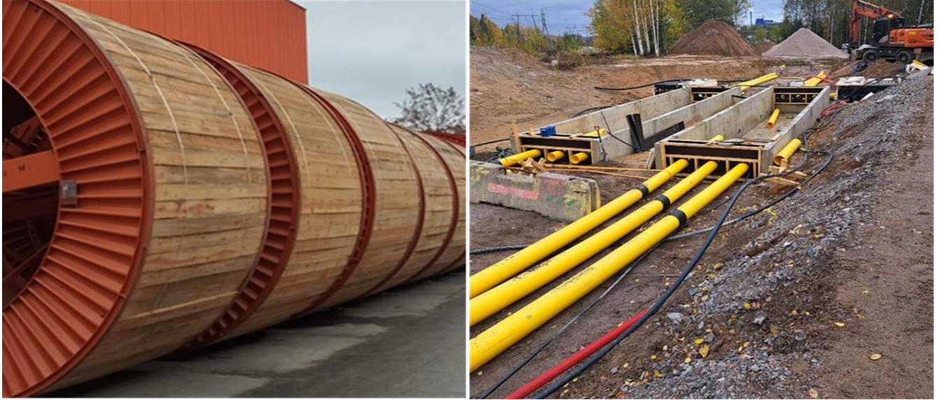
Kuva 4-1. 400 kV maakaapelia joudutaan asentamaan satojen metrien osissa – ilmajohtoa useita kilometrejä kerralla. Maa-kaapelijatkokset ovat hyvin isoja ja tarvitsevat kaapelia enemmän tilaa. Yksittäinen kaapelikela painaa noin 30 000 kg. Yhden kaapelinipun jatkot vaativat 12x2,6 metriä tilaa ja 2x400 kV voimajohtoyhteydessä on 7 kaapelinippua.
