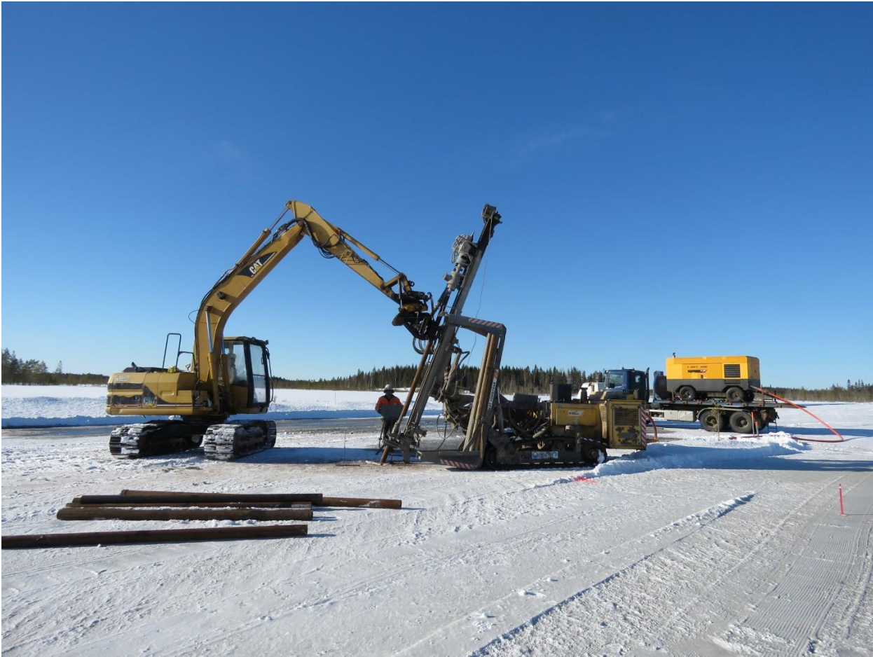
Kuva 3-6. Porapaaluperustuksen tekoa suoalueella, jossa työalue on jäädytetty.
