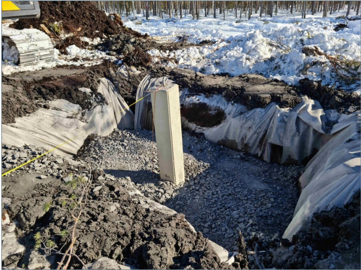
Kuva 3-4. Pylvään perustuselementin asentaminen.
