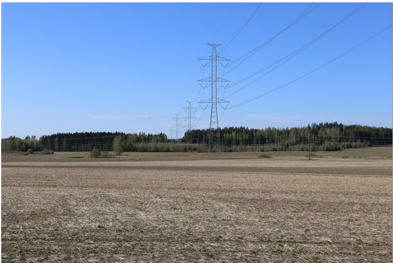
Kuva 12-14. Havainnekuva uuden voimajohdon sijoittumisesta Vantaanjoen-Kormun kulttuurimaiseman alueelle, Jusulantien eteläpuolella, Arolammin läheisyydessä. Havainnekuvasa on esitetty voimajohtoreitin osuus P_C-E, joka ylittää Vantaanjoen ja joen takana kulkevan 110 kV voimajohdon. Kuvauspaikka on esitetty kartoilla ja havainnekuvaliitteessä numerolla 6 (Liite 7).
