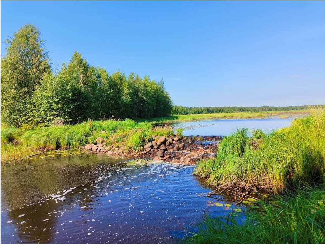
Kuva 5. Täydellisen vaellusesteen nro 1 muodostava pohjapato Alaojan suulla.
