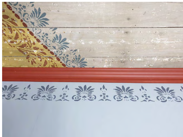
Kuva 8. Upea alkuperäinen kattomaalaus pääsi jälleen ihmisten nähtäville ja sai seurakseen seinän yläreunaa kiertävän sapluunakoristelun.
