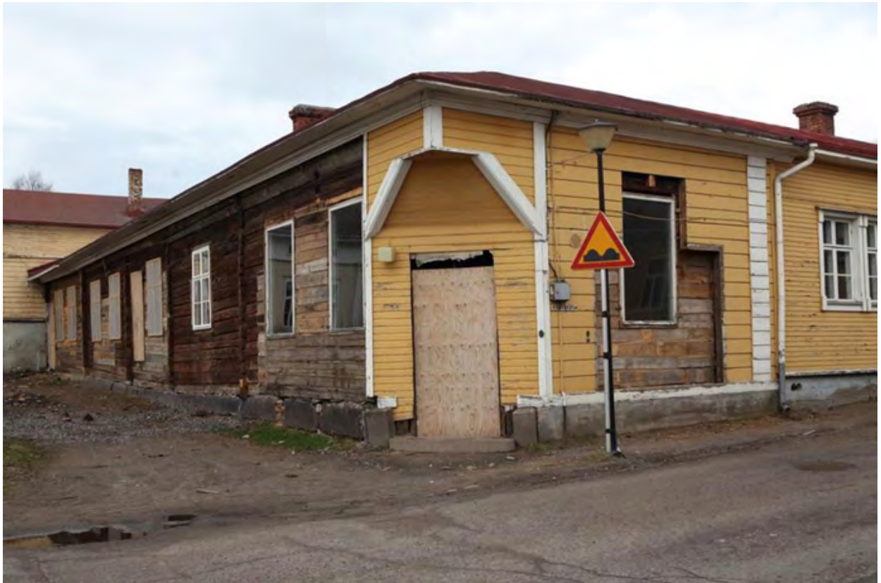
Kuva 1. Alkujaan vuonna 1811 valmistuneen Langin Alakartanon kunnostus alkamassa.
