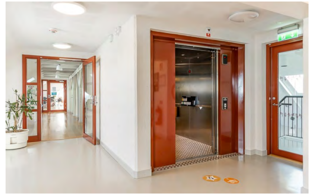
Kuva 33. Vanha tavarahissi vaihtui moderniin hissiin, joka suunniteltiin rakennusta varten.
