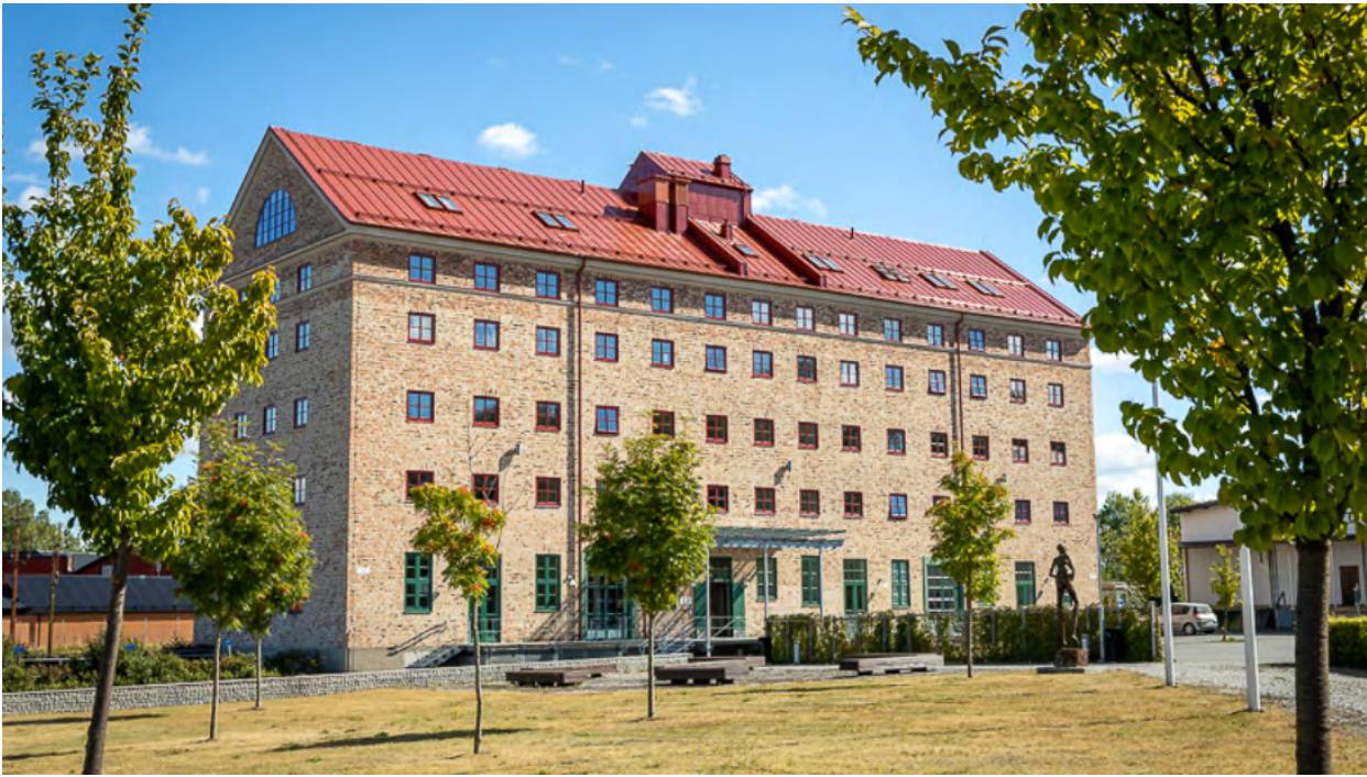
Kuva 31. Julkisivua on korjattu muun muassa uusilla, käsin tehdyillä tiilillä.
