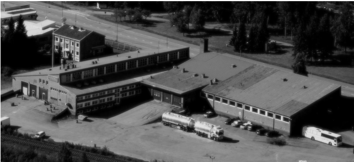
Kuva 55. Postiautovarikko ennen alkuperäisen käyttötarkoituksensa päättymistä.
