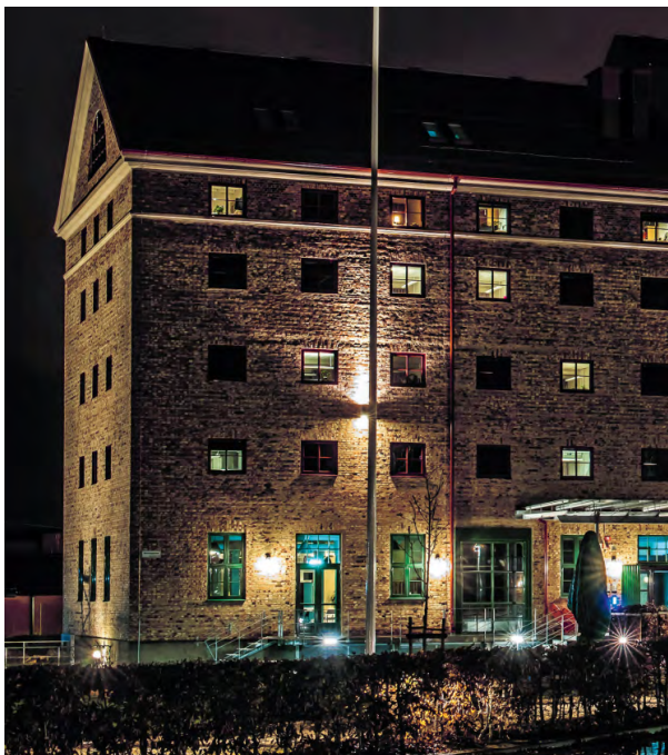
Kuva 35. Julkisivun valaisimet korostavat pimeään aikaan rakennuksen arkkitehtuuria ja kauniita tiiliä.
