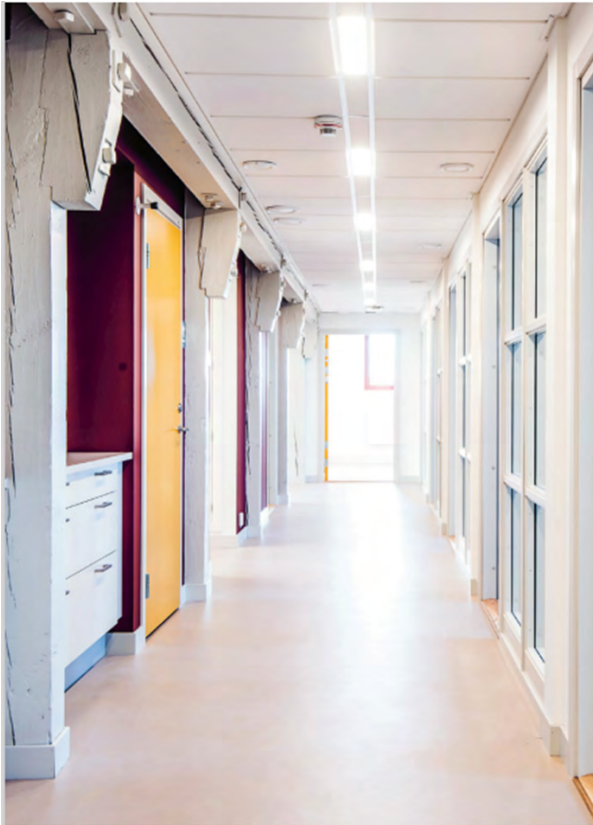
Kuva 32. Virastotalon käytävät on sijoitettu makasiinin vanhojen palkkien ja pylväiden väliin.
