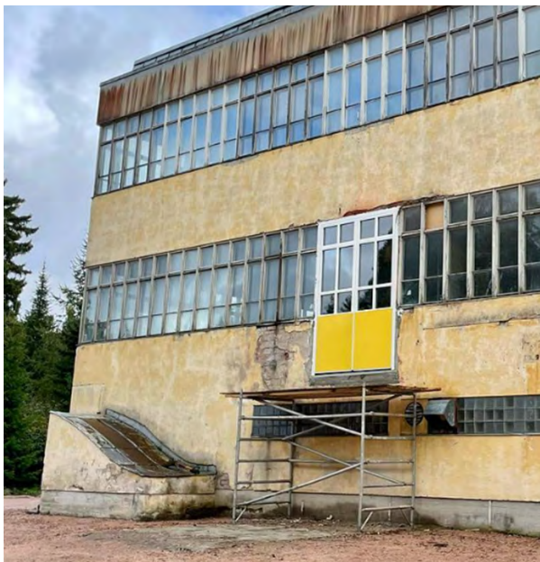
Kuva 70. Lastauslaiturille tehtiin uudet pariovet, joiden lasiosat jatkavat huomaavaisesti Ervin suunnittelemaa ikkunariviä.
