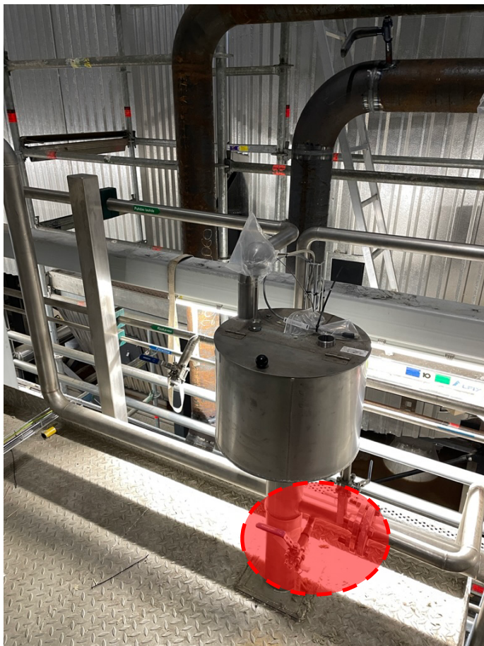
Kuva 6. Lauhteen välisäiliöstä ja näytteenottohana (merkitty punaisella).
