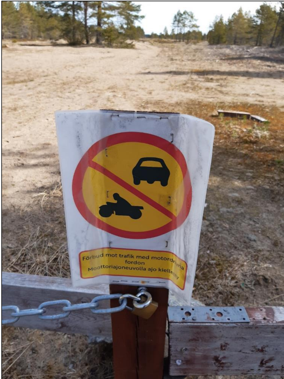
Bild 35. Skylten om att motortrafik är förbjuden bör bytas ut mot en skylt av ett mera hållbart material
