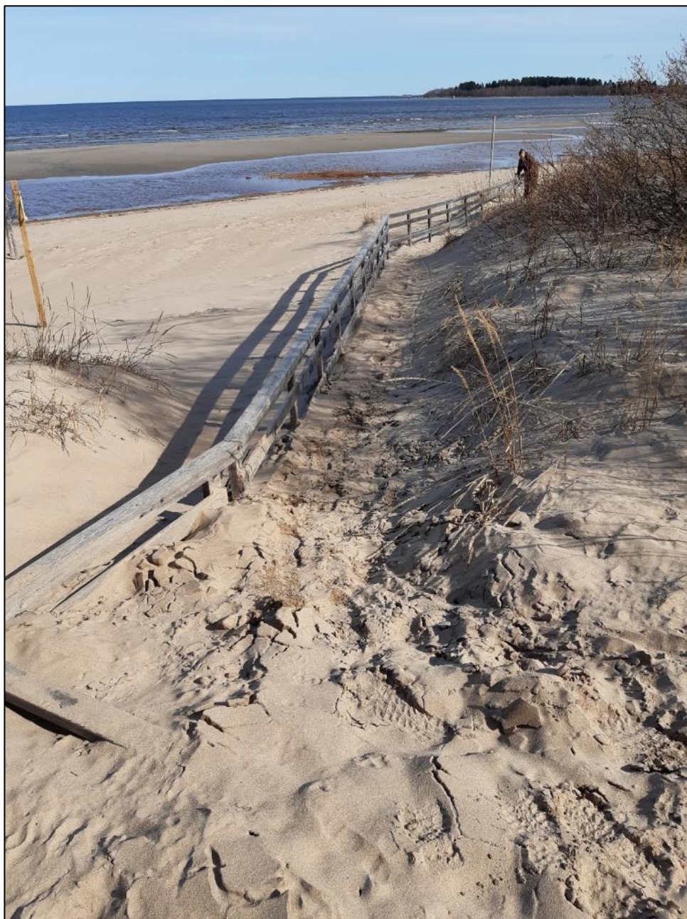
Bild 17. Den gamla västliga trallen var bitvis täckt av ett tjockt lager sand.
