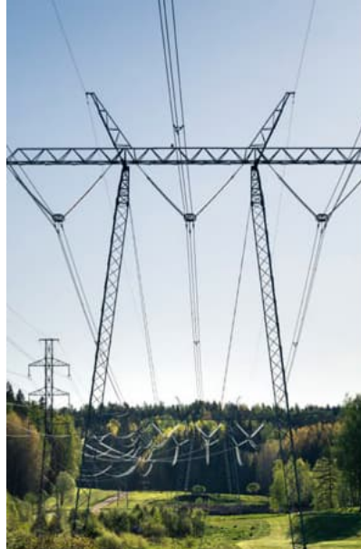
400 kV harustettu pylväs
