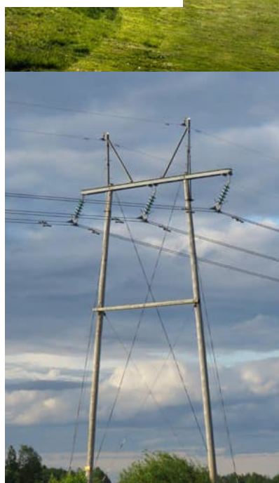
110 kV harustettu puupylväs
