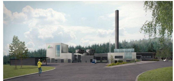
Kuva Sulkavuoren jätevesipuhdistamo
