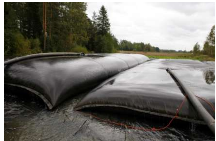
Levajärven geotuubiruoppaus, Kuva: Santtu Ahlman
