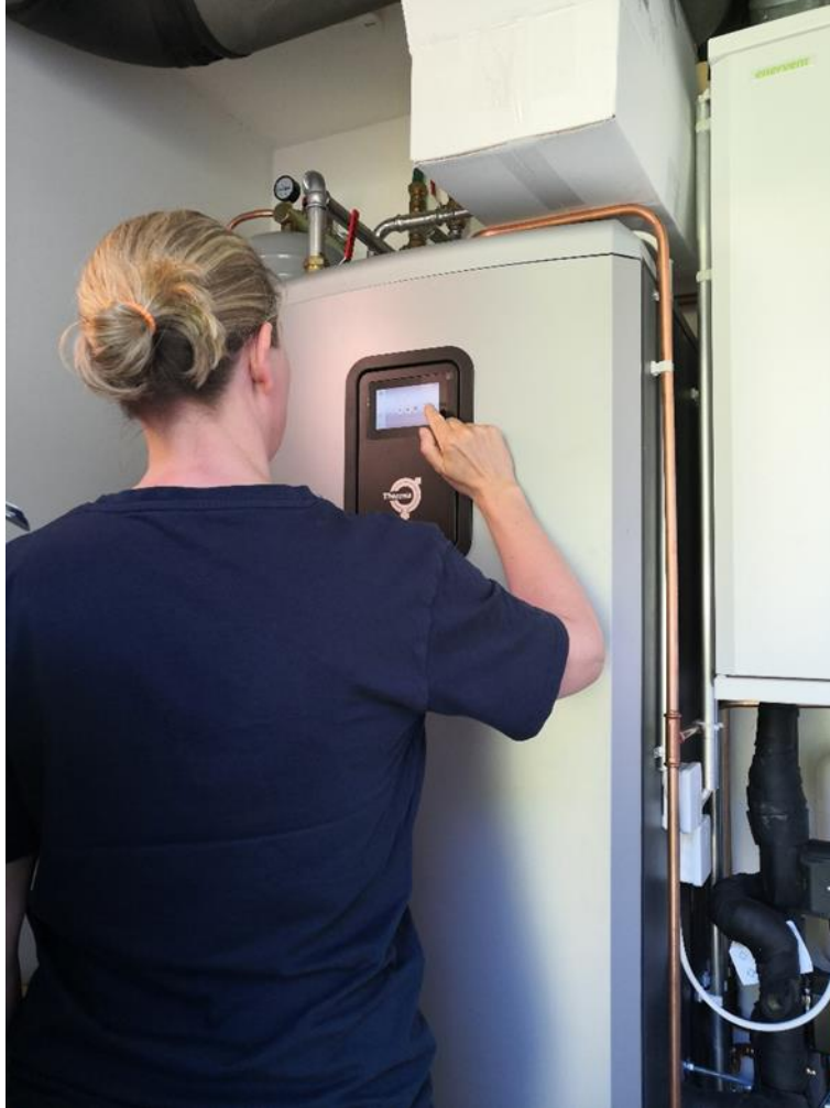
Lämpöpumpun sisäyksikkö. ©Etelä-Pohjanmaan ELY-keskus.
