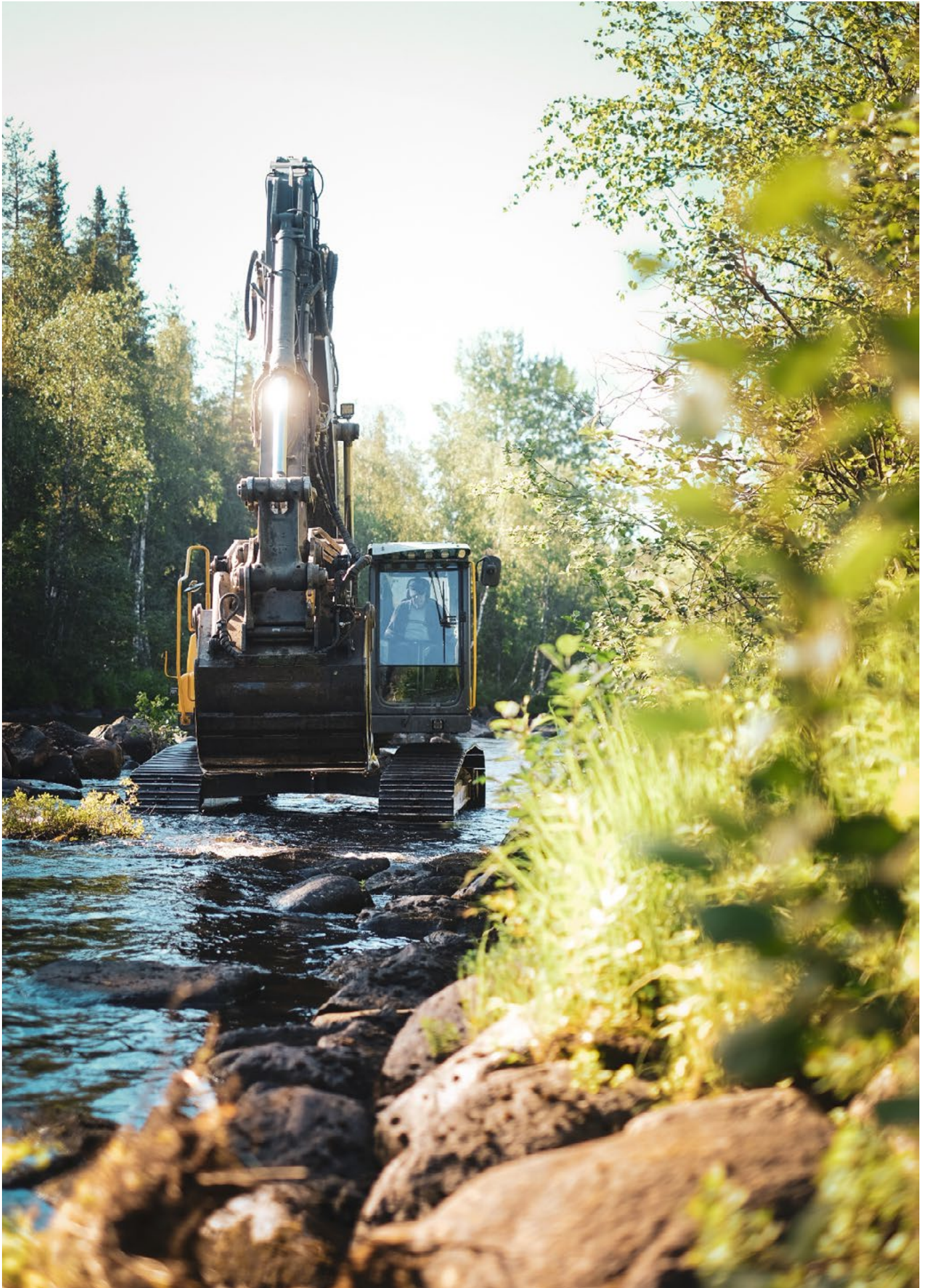
Vesistöjen kunnostukset tehdään usein kaivinkoneella. Kunnostusten tavoitteena on palauttaa vesistö lähemmäksi luontaista tilaansa. Kuva: Jeremias Kinnunen-Levy
