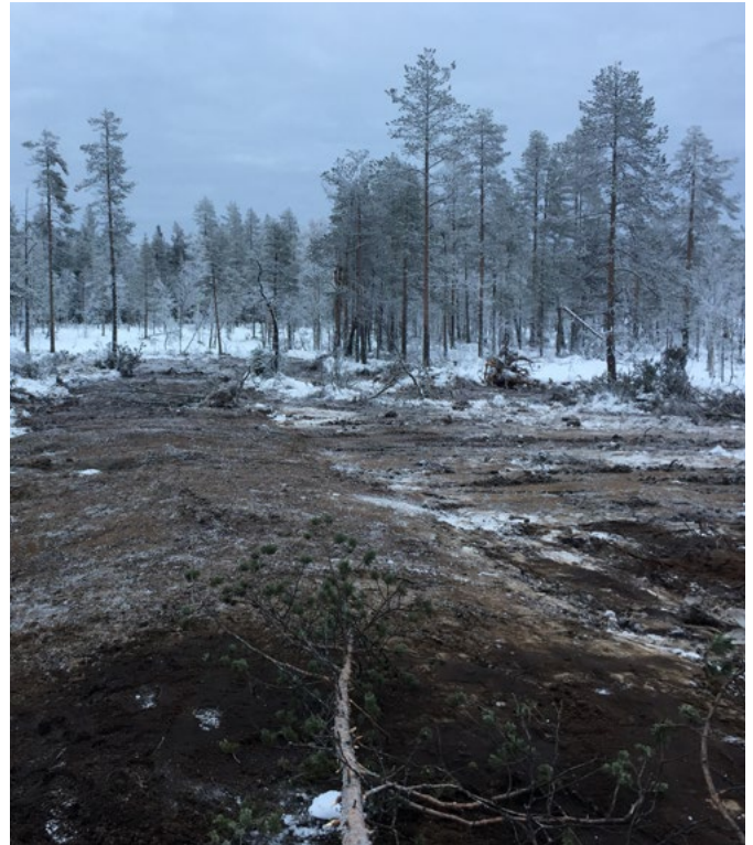
Umpeen täytetty oja. Täyttöturve muodostaa kumpumaisen rakenteen.
