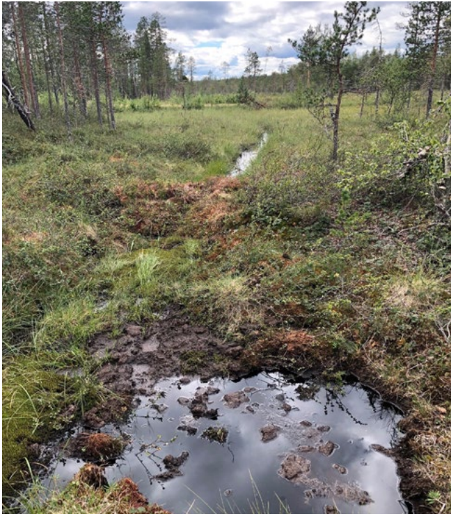
Ojakatkos, jonka päälle on asetettu turvetta padon tiivistämiseksi.
