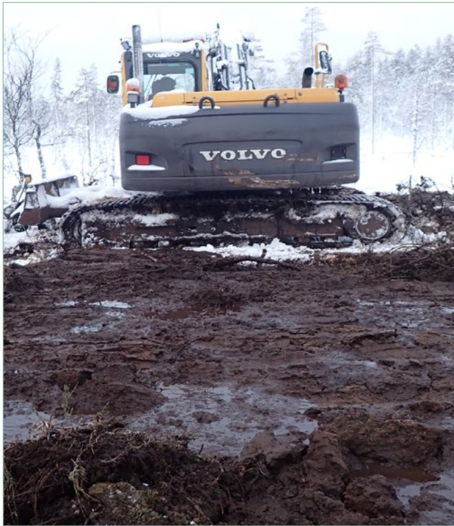
Kuivatusojan täyttöön käytetään ojan reunoille nostettua turvetta.
