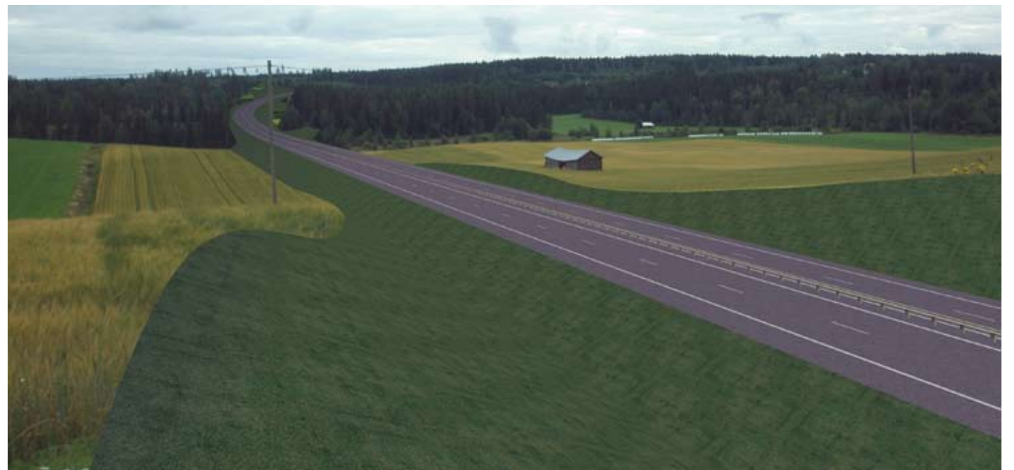
Kuva 63. Vaihtoehtojen 3a ja 3b toteutuessa syntyy paikoitellen suuria maaleikkauksia alueen vaihtelevasta topografiasta johtuen. Kuvapari ennen ja jälkeen Rokkakoskentieltä.
