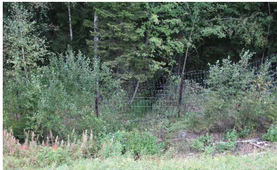
Kuva 5.4 Valkjärven lasku-uoma valtatiepenkereen länsipuolella.
