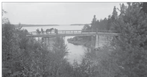
Aunessillan seutu on ollut 1800-luvun lopulla melko eri näköinen verrattuna nykyhetkeen. Kuva on vuodelta 1891. Puusto on ollut hyvin matalaa. Puusilta on rakennettu poikkeuksellisen korkeiden arkkujen varaan, jotta sen ajan höyrylaivat ovat mahduneet kulkemaan sen ali laituriin. Lähde Tampereen Museot, Siiri -kuvatietokanta
