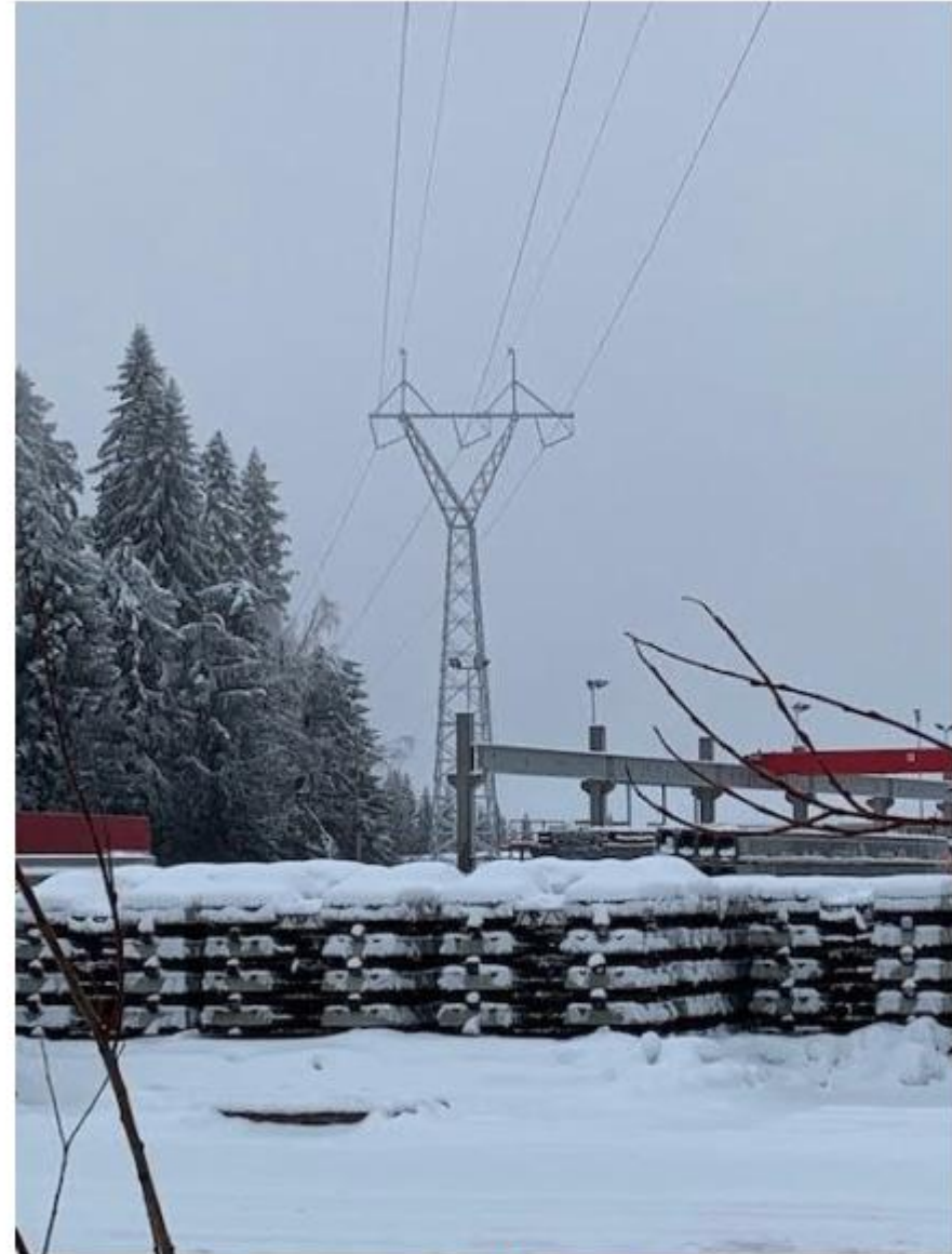
Kuva 7. Kuva pylväältä 2 johtimien asennuksen jälkeen.
