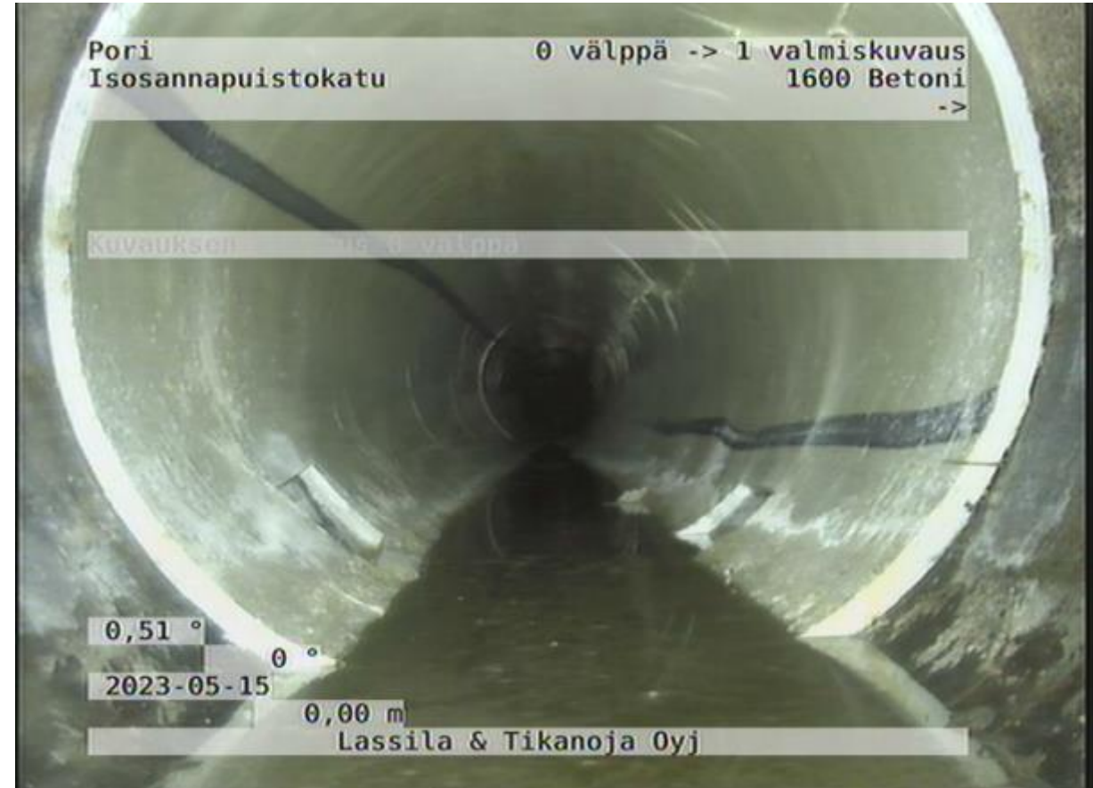
Betoniputkeen asennettu 80mm lasikuitusukka.
