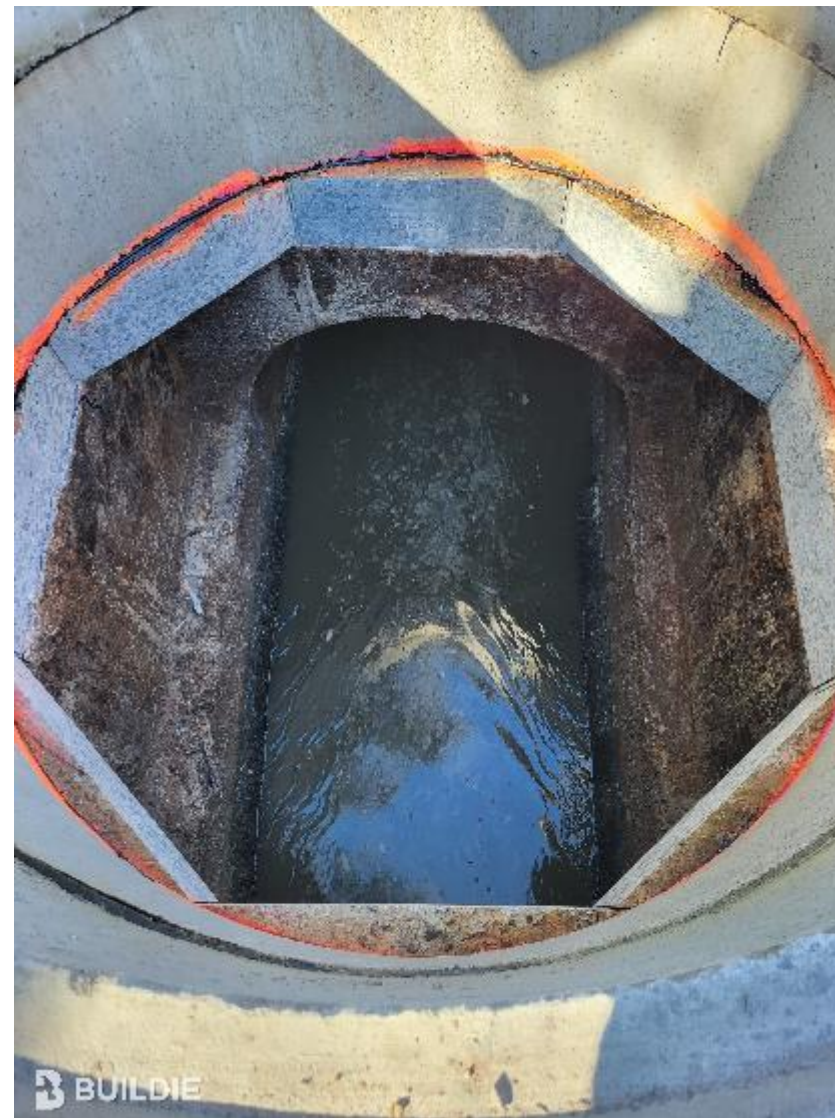
Sukan asennusta varten kaivoa suurennettiin DN 2000.
