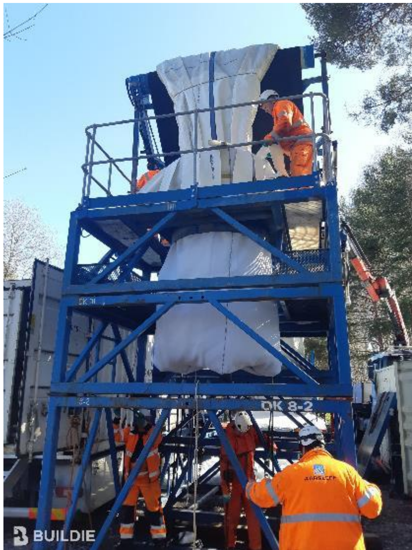
Sukan asennusta. Asennus saneerattavan linjan puolesta välistä.
