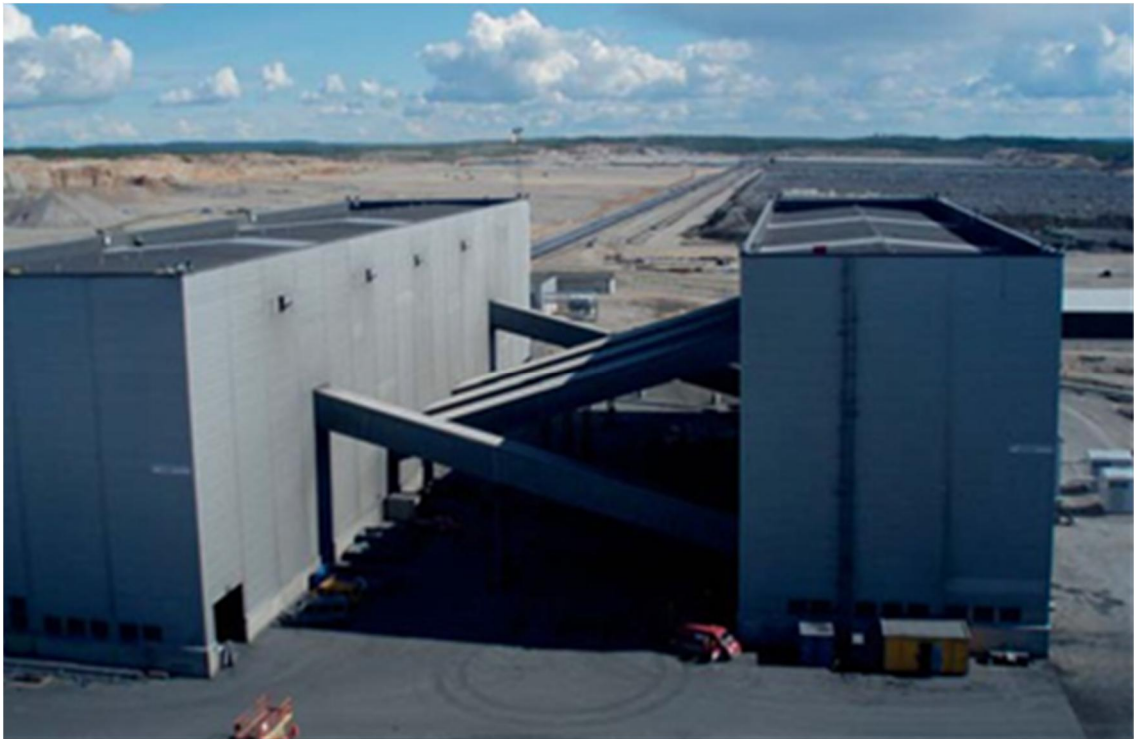
Kuva 3-6. Seulonta ja hienomurskaamo (Ramboll Finland Oy 2012).
