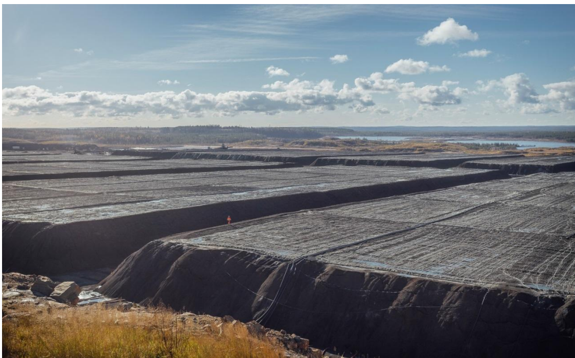
Kuva 3-8. Primääriliuotusalue (Terrafame 2015). Yhden kentän koko 400 m x 1 200 m ja malmikerroksen korkeus 6...12 m.
