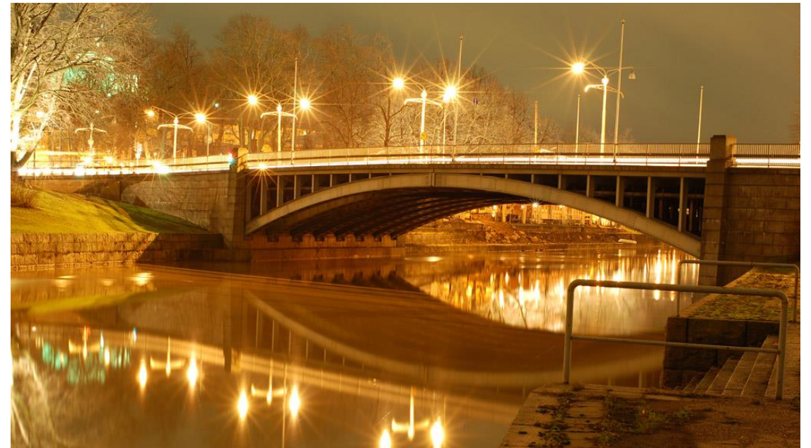
Tuomiokirkkosillan valaisimissa on raitiovaunujen ajolankakiinnityksiä. Kuva: Wikimedia Commons
