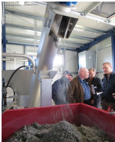
Kuvat 12 -14. Salzgitter GmbH jätevesilaitoksella on biologinen jätevedenpuhdistusprosessi ja lietteen biokaasutus sekä struviitin fosforin talteenotto.
