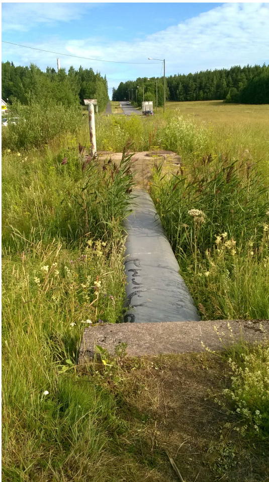
kuva: lämpökanaalin ylityskohta
