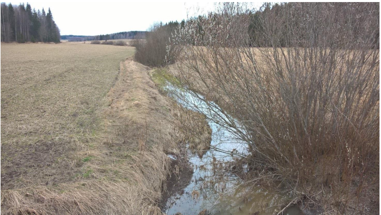
Kuva 6: Mättäänoja huhtikuussa 2016. Uomaan rakennetaan tulvatasanteet vuosien 2017–18 aikana.
