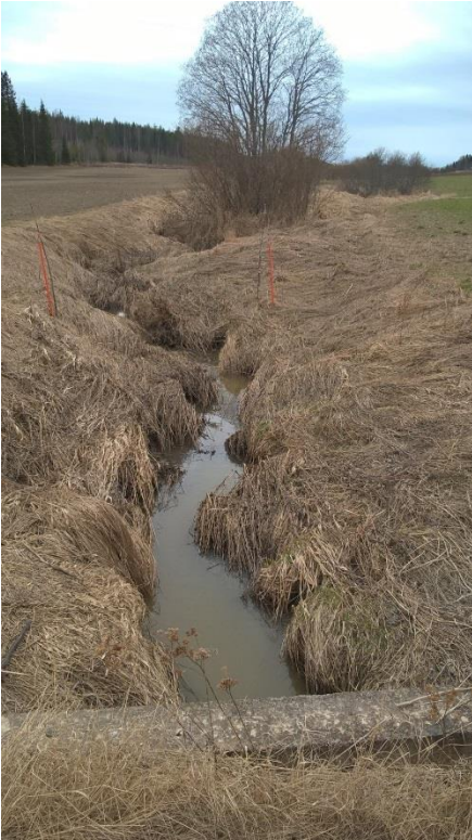
Kuva 7: Mättäänojan sivu-uoma, jonka suurta pohjaeroosiota tullaan hillitsemään pohjapadoilla.
