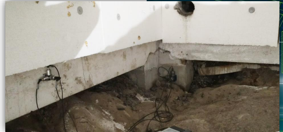
Kuva: Referenssimittaus rakennuksen perustuksista
