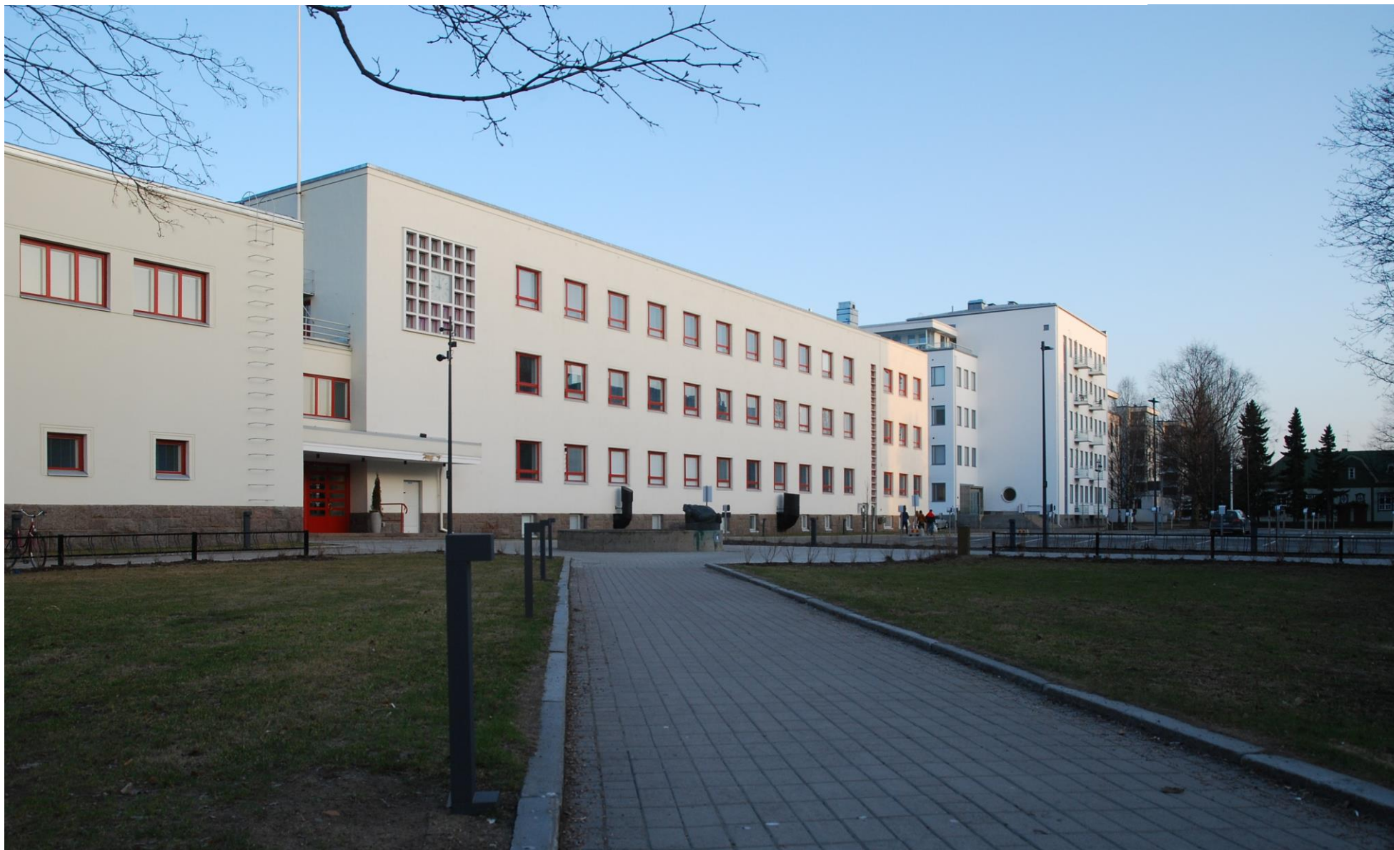
Sammakkotalo ja As Oy Oulun TEKU: Kuva: Touko Linjama / Pohjois-Pohjanmaan ELY-keskus
