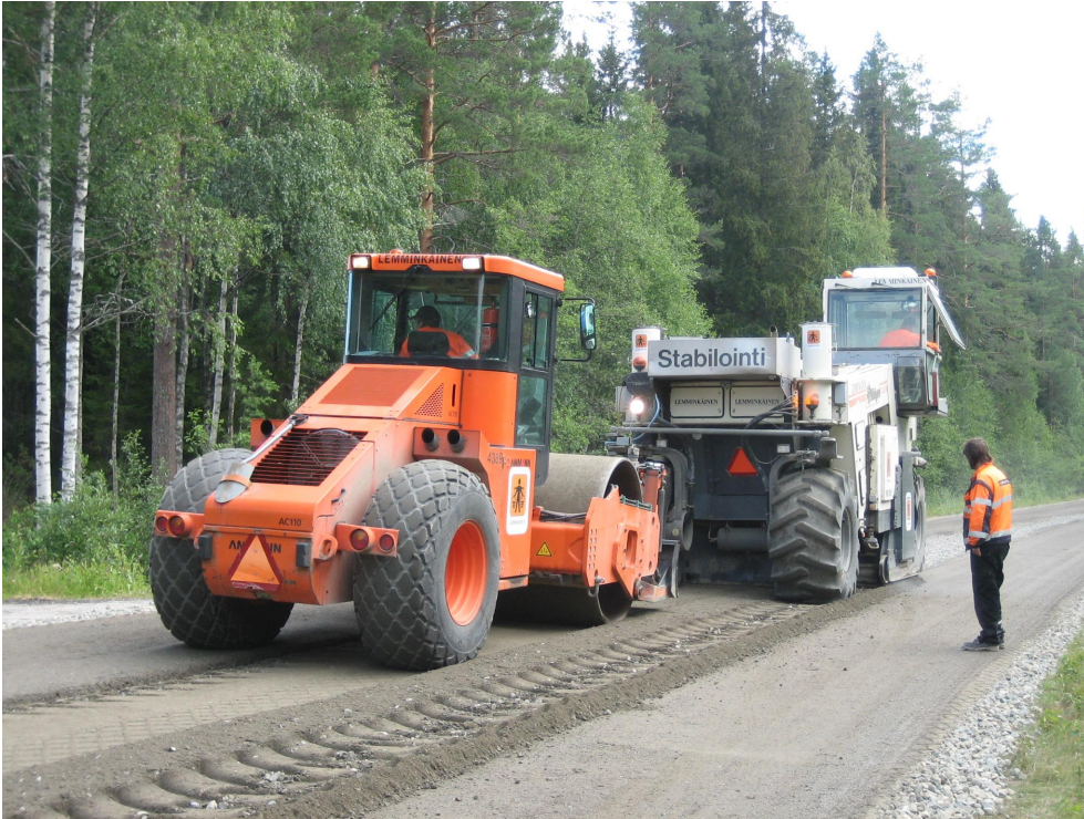
Kantavan kerroksen parantamista ennen päällystystyötä.
