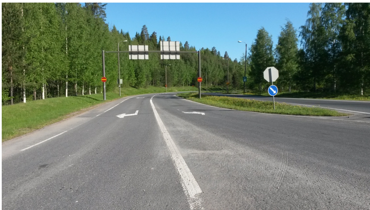
Siilinjärven eritasoliittymän ramppi pohjoisesta (Iisalmesta tuleva liikenne)
