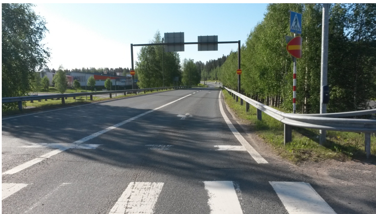
Siilinjärven eritasoliittymän ramppi etelästä (Kuopiosta tuleva liikenne)
