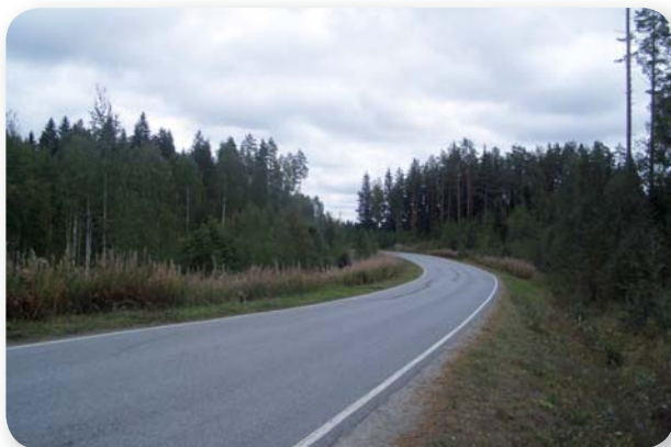
Kuva 23. Näkymä Porrassalmentie uudelta tielinjalta tien eteläpäässä
