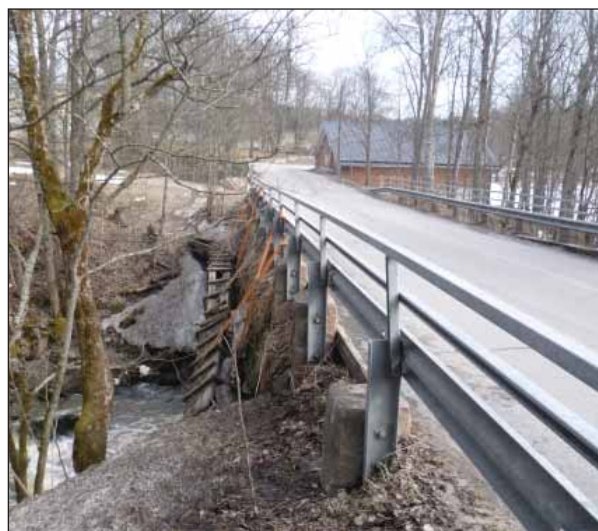
Vanhoja sillan kaiteita on jatkettu korottamalla niitä teräskai-teella. Kaapelikotelot roikkuvat liinojen varassa. Tien taseus on noussut jopa 70 cm ja vanhat kaiteet ovat jääneet liian mataliksi. Kokonaisuus ei ole kulttuurihistoriallisesti merkittävän miljöö arvon mukainen. Kuva Laura Soosalu.
