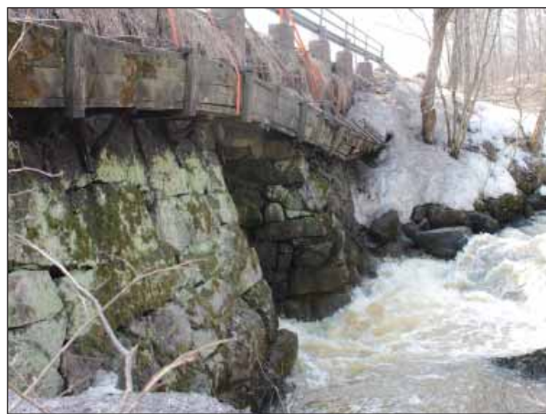
Sågbro yläjuoksulta kuvattuna. Kuvassa näkyy liinoilla kannateltu lahonnut puinen kaapelikotelo ja teräskaide. Teräskaiteen alapuolella erottuvat alkuperäiset kiviset kaidepilarit. Kuva Petra Kotro.
