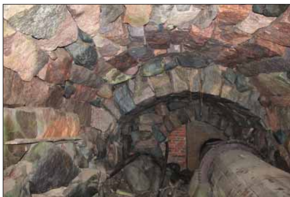
Qvarnbron holvaukset kuvattuina yläjuoksulta päin. Tiiliseinän vasemmalla puolella erottuu myllyrakennuksen vanhan harmaakiviseinän rakenne, jossa on holvattu aukko veden johtamista varten. Tiiliseinä on todennäköisesti muurattu myllyn sähköistämisen yhteydessä 1910-luvulla. Keskellä erottuu alkuperäistä kiviholvia matalampi holvikaari, joka on rakennettu eri tavalla lohkotuista kivistä kuin vuosina 1775–1777 rakennettu kiviholvi. Oikealla näkyy teräksinen veden syöttöputki. Kuva Petra Kotro.
