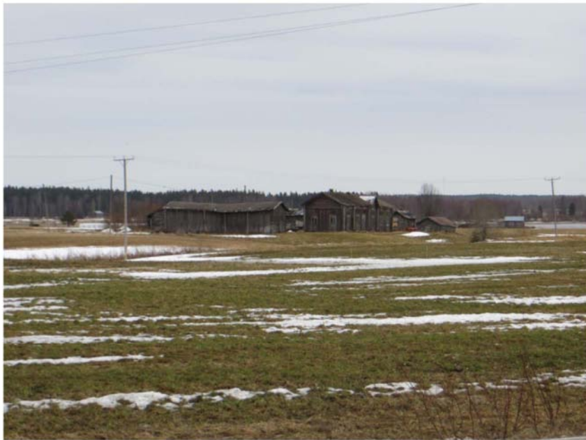
Kuva: Hieno rakennusperintö, mutta heikossa kunnassa.
