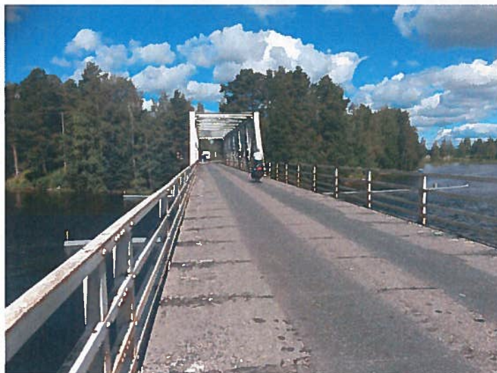
Kuva 3. Nykyisen sillan yläpuolinen rakenne
