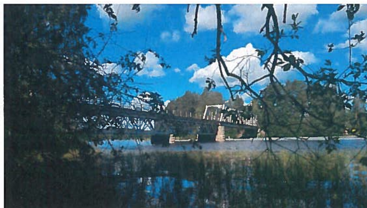
Kuva 4. Nykyinen silta (vesiliikenteen reitti uloimmassa silta-aukossa)
