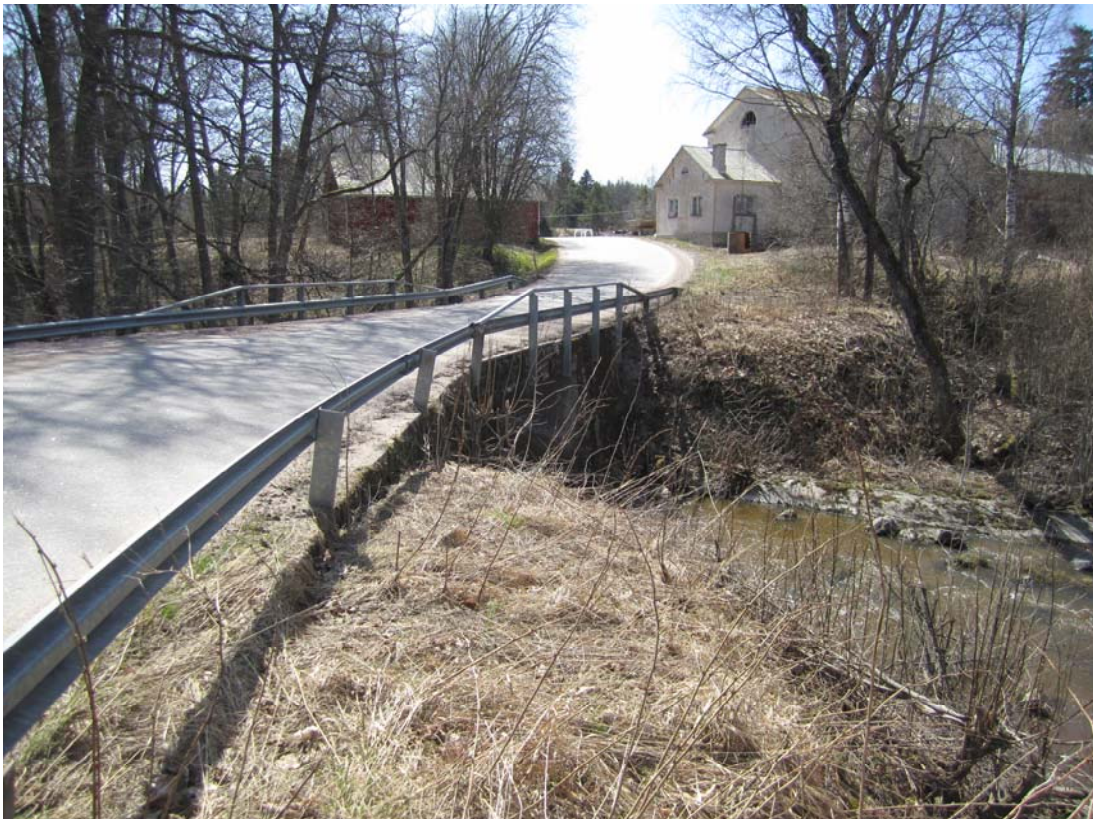
Sunnanån silta pohjoisesta päin katsottuna
