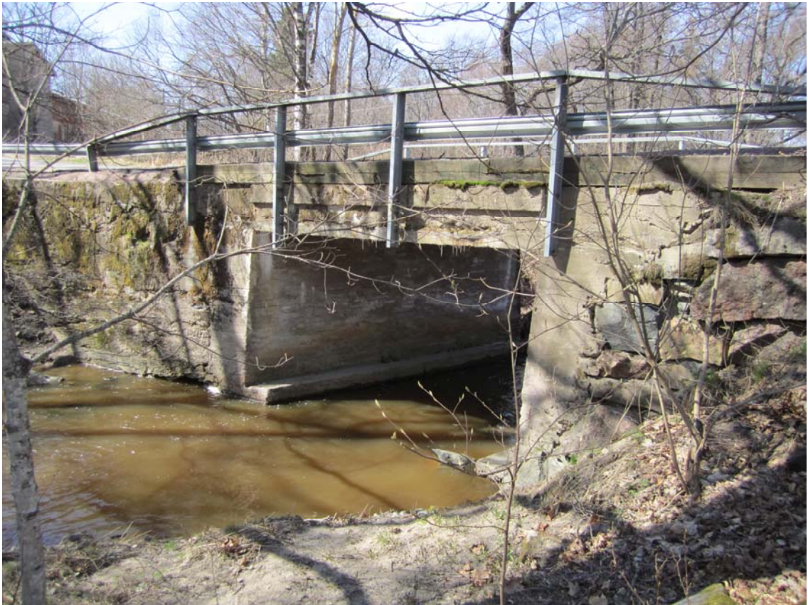
Silta yläjuoksulta katsottuna
