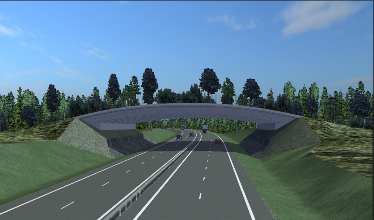
Eläinten kulkuyhteyksien turvaamiseksi Kivistönmäkeen rakennetaan vihersilta.
