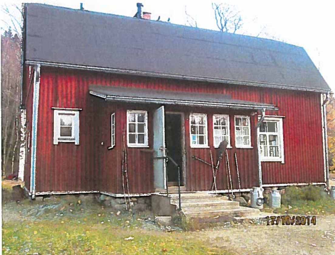
Konttila, entinen pappilan torppa vanhimmilta osiltaan vuodelta 1775 (seinähirret dendrologisen iänmäärityksen mukaan). Peruskorjattu 1930-luvulla ja vuonna 2002. Katon korotus ja muutos mansardikatoksi on tehty 1930-luvulla.
