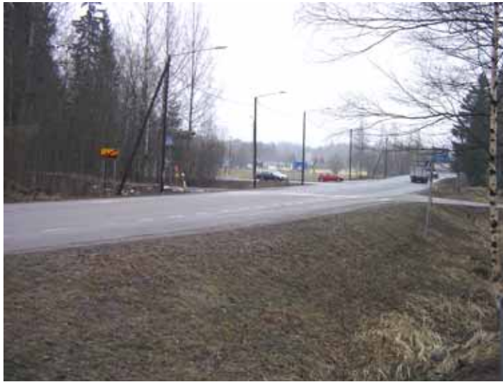
Kuva 28. Järvenpäätiellä suurimmaksi ongelmakohteeksi koetaan Poikkitie (mt 145) liittymä. Ruuhka-aikoina Poikkitieltä liittymisen Järvenpääntielle on vaikeaa.
