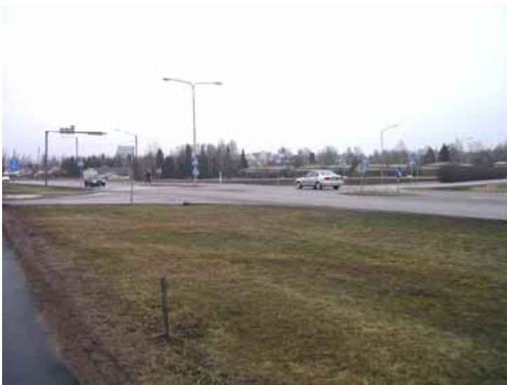
Kuva 27. Sipoontien ja Sibeliuksenväylän liittymä koetaan hankalaksi autoilijoille ja turvattomaksi jalankulkijoille ja pyöräilijöille.
