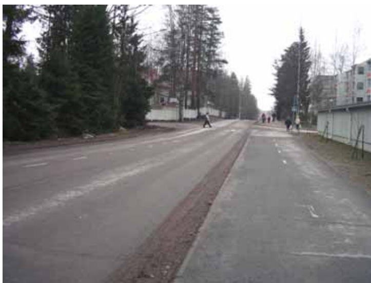
Kuva 30. Kaskitien ja Välskärinkadun liittymää pidetään erityisen hankalana heikkojen näkemien takia. Liittymä on tasa-arvoinen.
