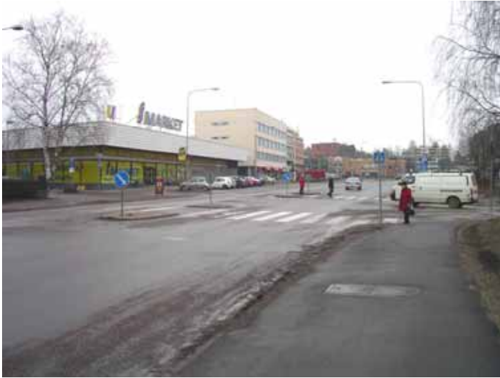
Kuva 25. Helsingintiellä ongelmalliseksi koetaan puutteelliset tiemerkinnot ja liikennevaloliittymät. Eriyksen hankala ja onnettomuusaltti paikka sijaitsee S-Marketin edessä, jossa pysäköinnistä poistuvat autot kääntyvät usein ajamaan vastaantulevien suuntaan.
