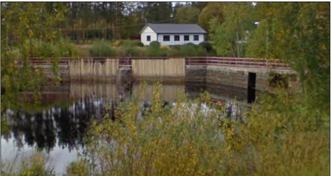
Kuva 3. Tulva-aukot suljettuna syyskuussa 2009.
