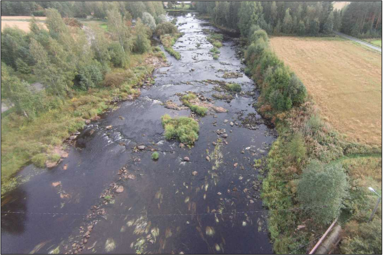
Kuva 1. Lakaluoman padon yläpuolista kivikkoista koskialuetta.
