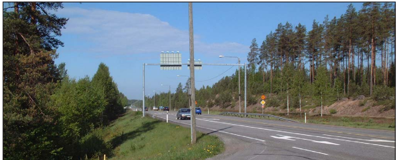
Kuva 14 Kouvolan ja Utin välille ehdotetaan rakennettavaksi kapea nelikaistainen tie, jossa tasoliittymät on korvattu eritasoliittymillä, kuva Häkämäen liittymästä
